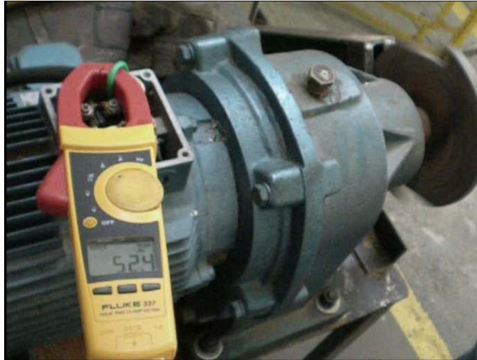
Figura 13. Valor máximo de corriente durante el arranque sin carga.
