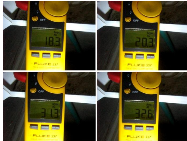
Figura 83. Registros de corriente con la máquina trabajando.
