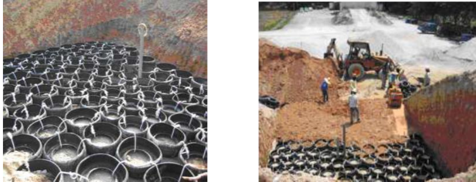
Disposición y llenado de los neumáticos
