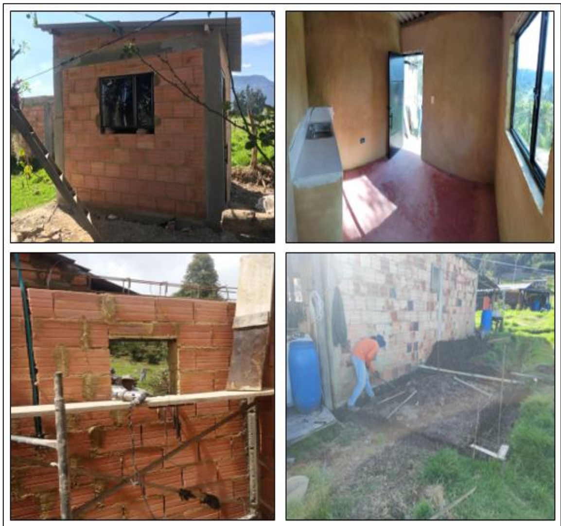
Figura 12. Registro fotográfico, construcción de mejoramiento de vivienda en la zona rural del municipio de Simijaca – Cundinamarca.
