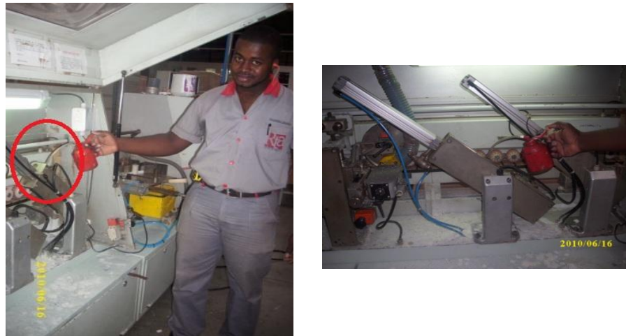
Figura 40. Limpieza de cilindros neumáticos de los retestadores.
