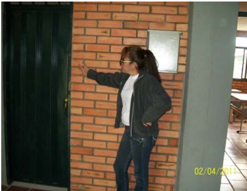
Figura 38 Ubicación IDF's del segundo Piso
