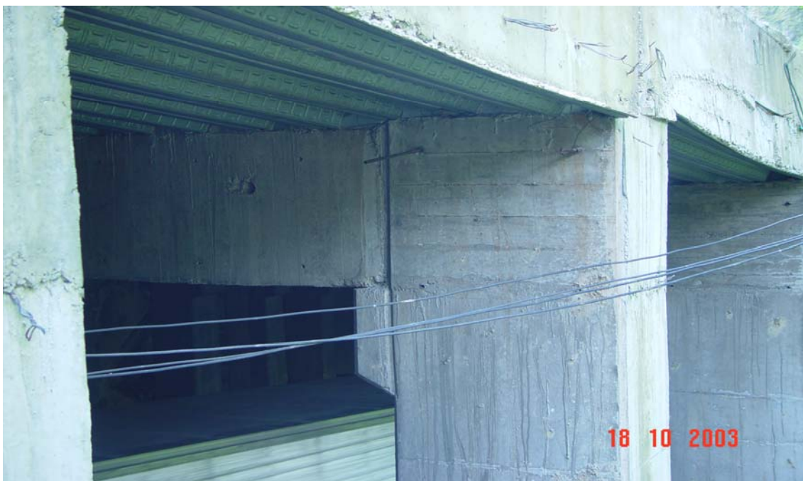
Foto 20: Detalle apoyo - túneles de Quebrada blanca
