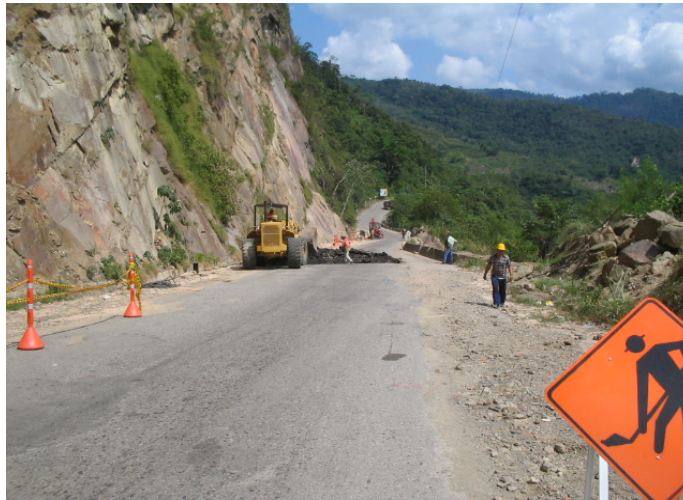
Foto 39: Inicio democión del pavimento existente
