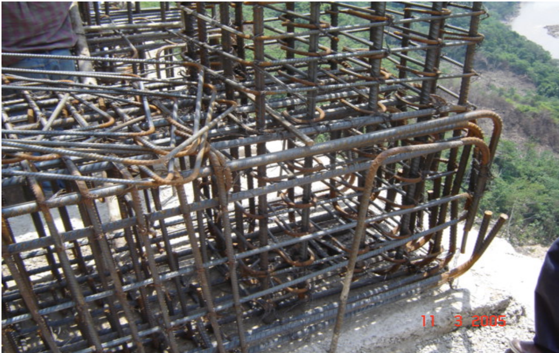
Foto 62: Detalle del refuerzo en el nudo – viga cimentación columna
