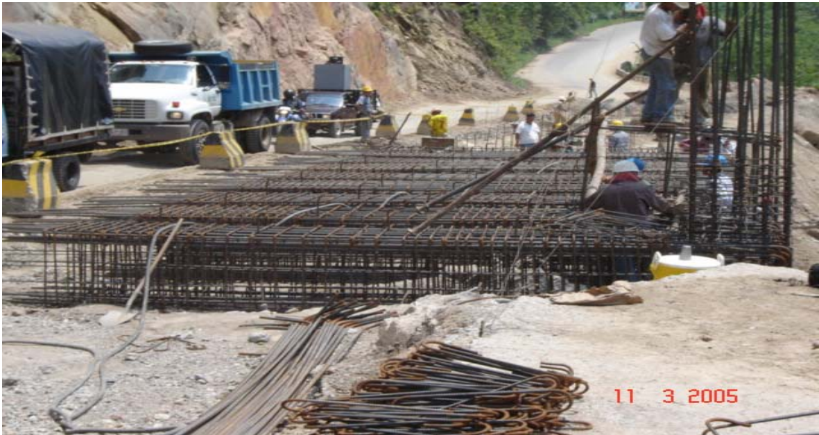
Foto 4: Refuerzos de vigas VCT-Túnel Falso Cerro de San Pablo
