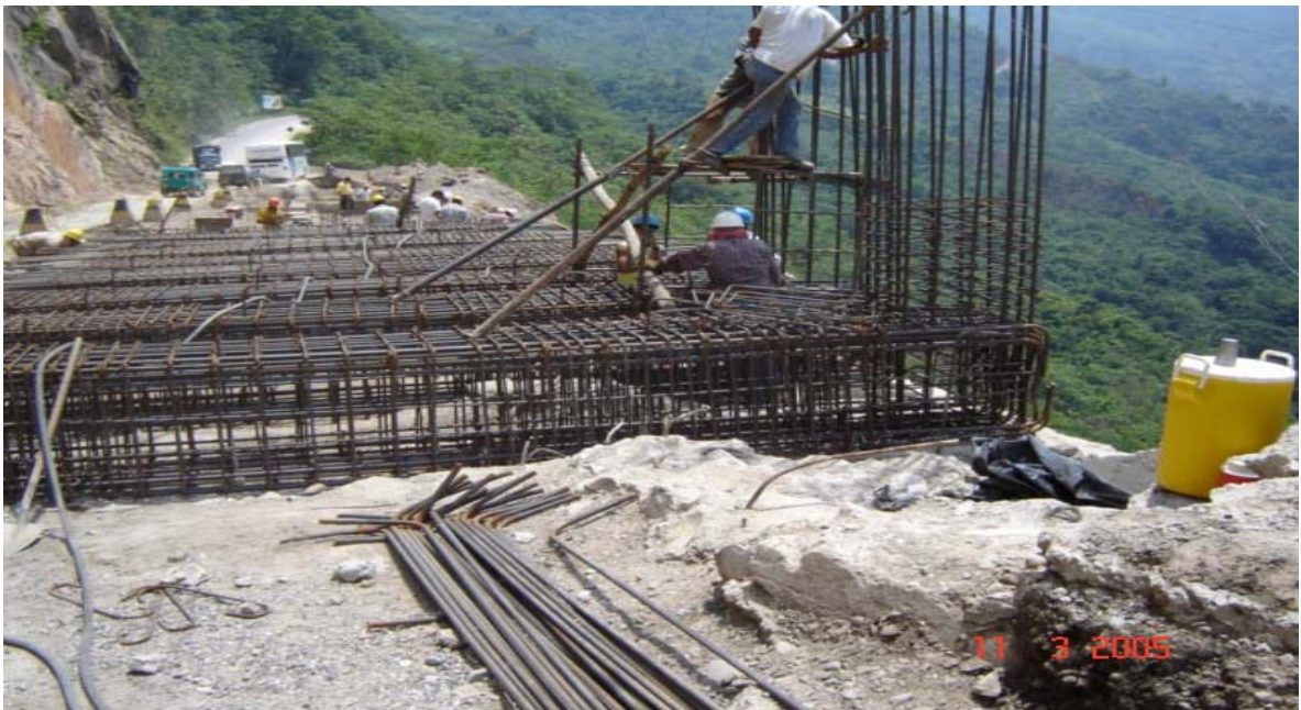
Foto13: Armado de refuerzos de vigas de cimentación – Túnel Falso Cerro de San Pablo
