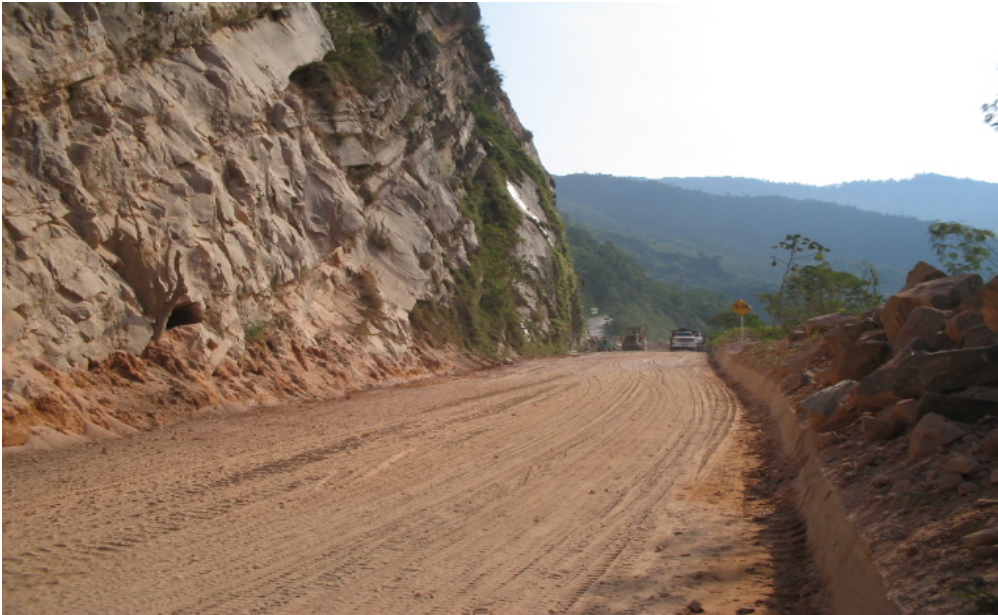
Foto 51: Vista del sitio adecuado para la iniciación de la construcción
