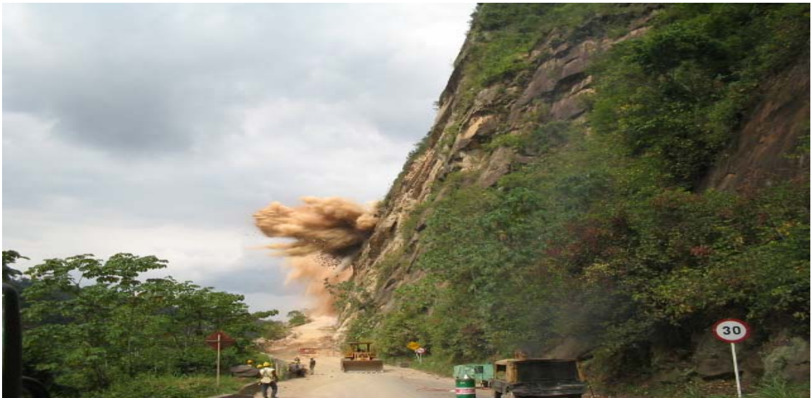
Foto10: Voladuras de roca – Túnel Falso Cerro de San Pablo
