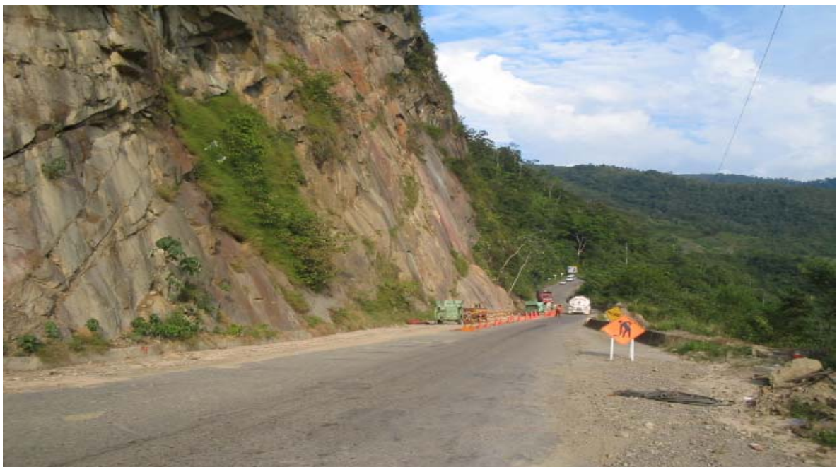
Foto 11: Adecuación de la vía – Túnel Falso Cerro de San Pablo
