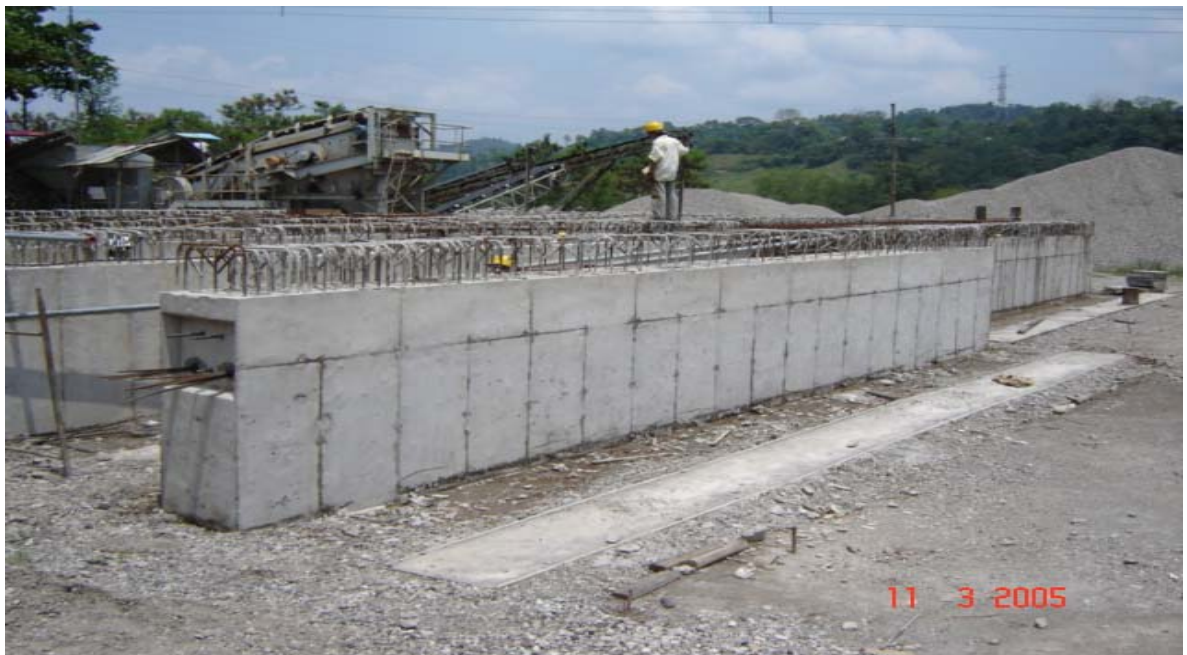
Foto 9 : Vigas prefabricadas –Túnel Falso Cerro de San Pablo
