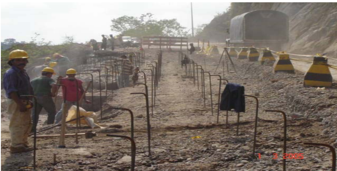
Foto 5: Anclajes -Túnel Falso Cerro de San Pablo
