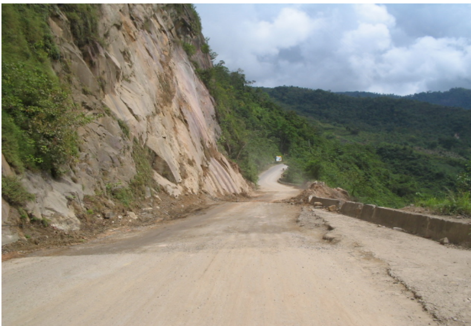
Foto 45: Caras limpias del talud luego de remover los bloques salientes
