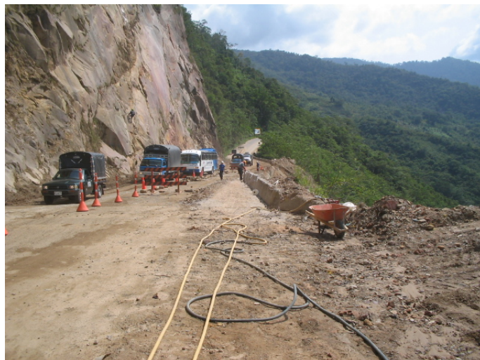
Foto 55: Construcción de las submuraciones
