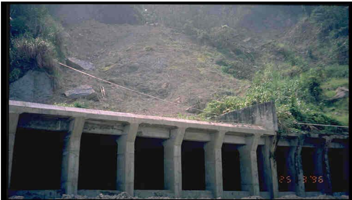
Foto 25: Túnel falso con vigas cajón y soportado sobre mensulas
