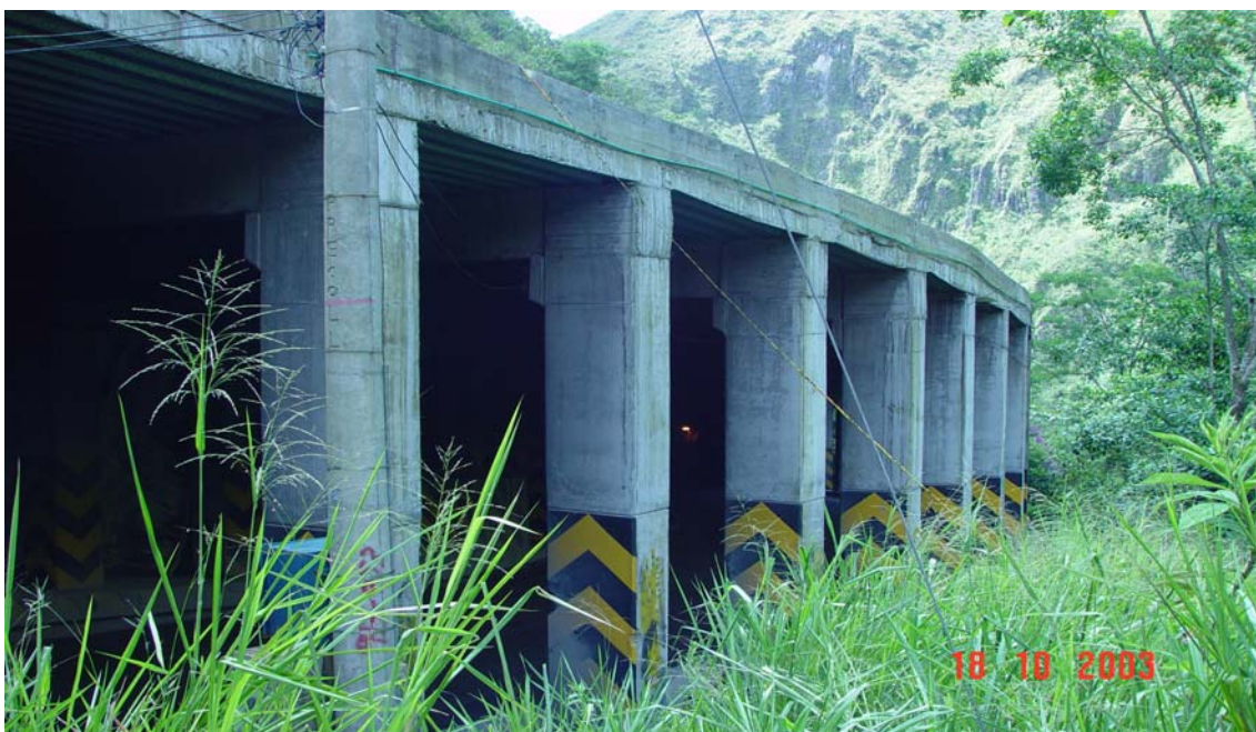
Foto 18: Vista frontal del túnel de Quebrada blanca
