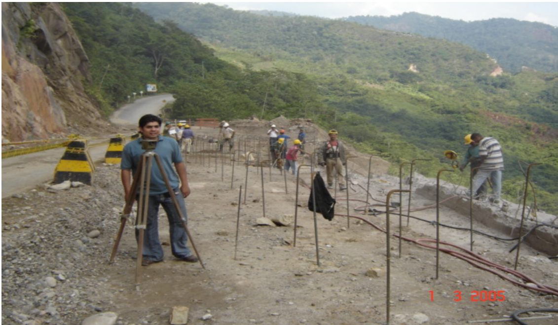
Foto 60: Revisión topográfica de ubicación de anclajes
