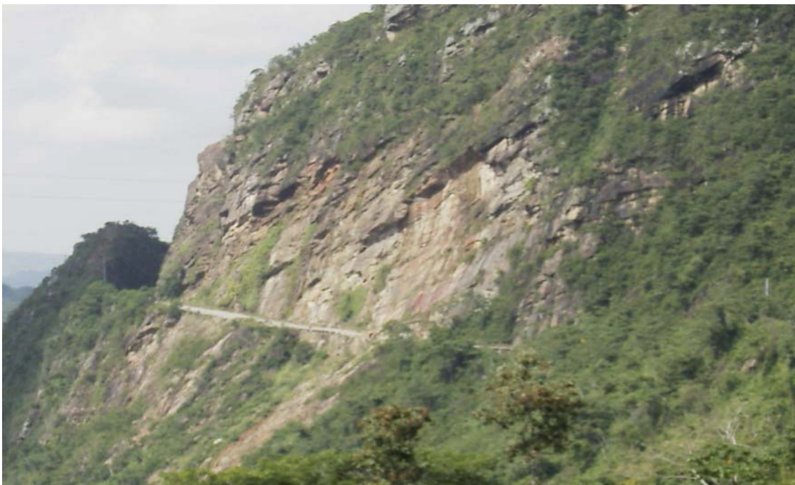
Foto 30: Vista previa del talud
