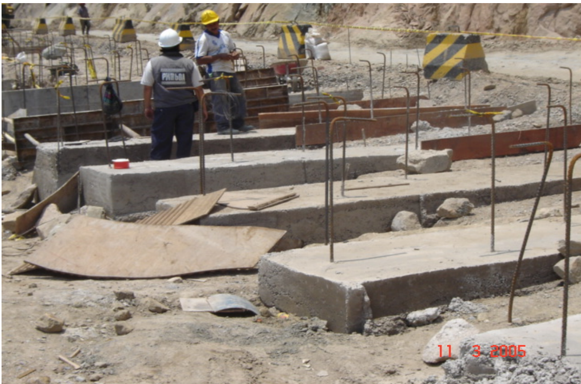
Foto 73: Soportes para las vigas de cimentación
