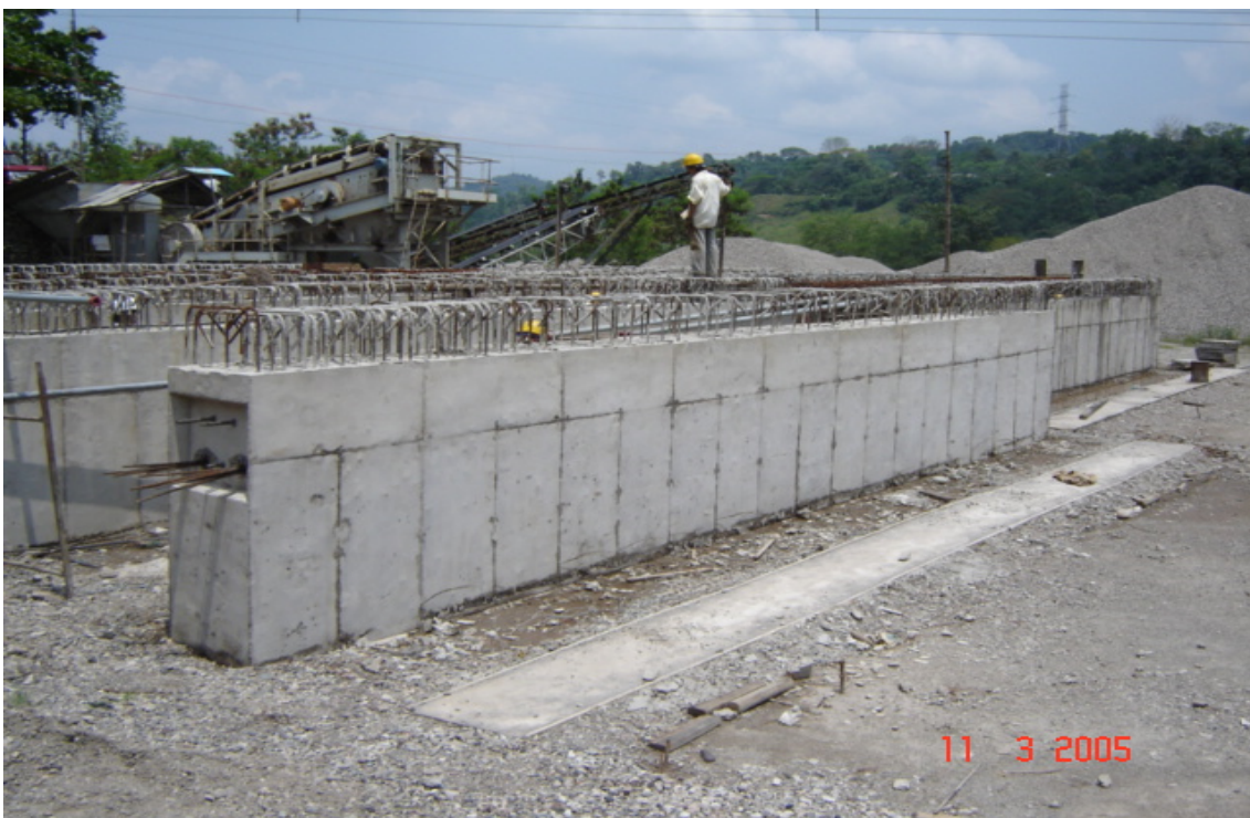
Foto 67: Vigas prefabricadas VA- Detalle refuerzo de amarre a la losa
