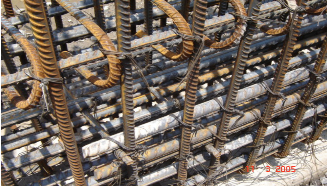
Foto 64: Detalle de amarre de estribos - Viga VA
