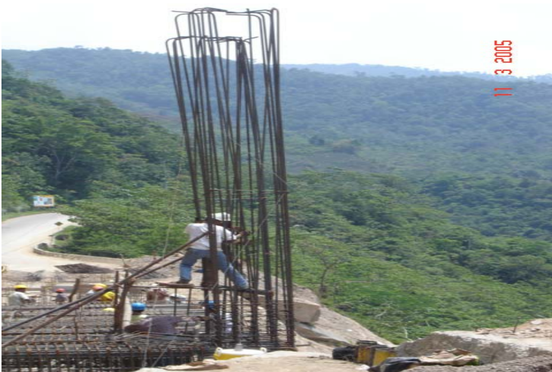
Foto 63: Colocación de estribos en la columna
