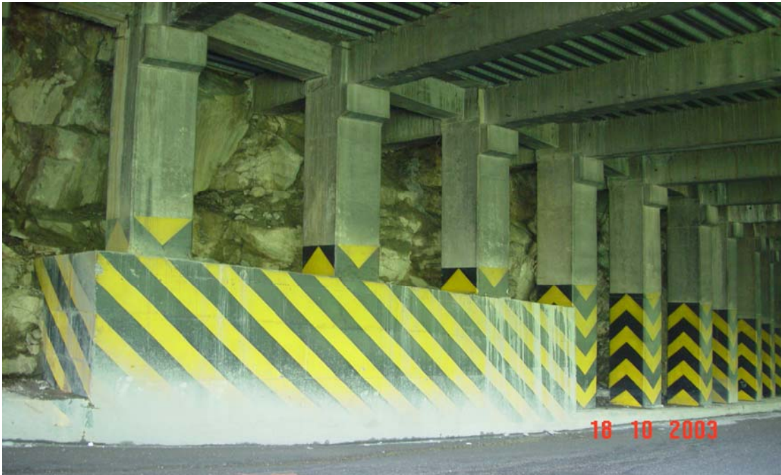
Foto 15: Detalle columnas de los túneles de Quebrada blanca
