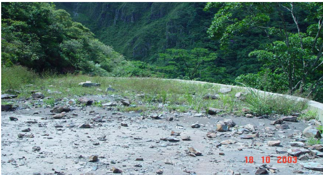
Foto 19: Placa- túneles de Quebrada blanca
