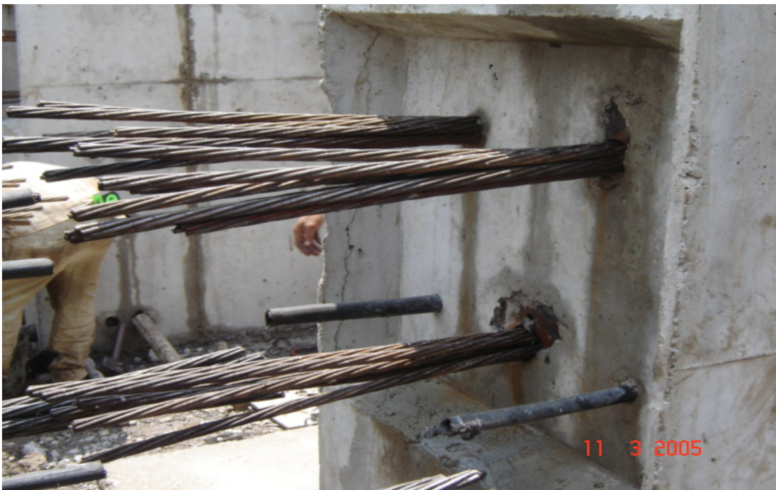
Foto 65: Detalle de torón viga VA
