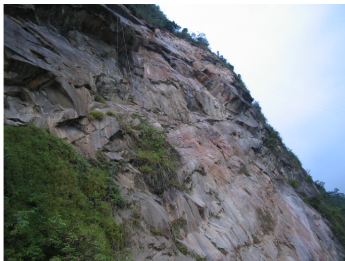
Foto 43: Instalación de explosivos
