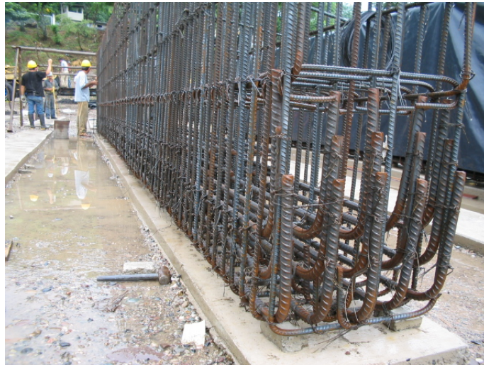
Foto 54: Detalle de refuerzo viga VA - ganchos
