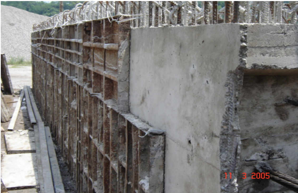
Foto 66: Retiro de steel deck
