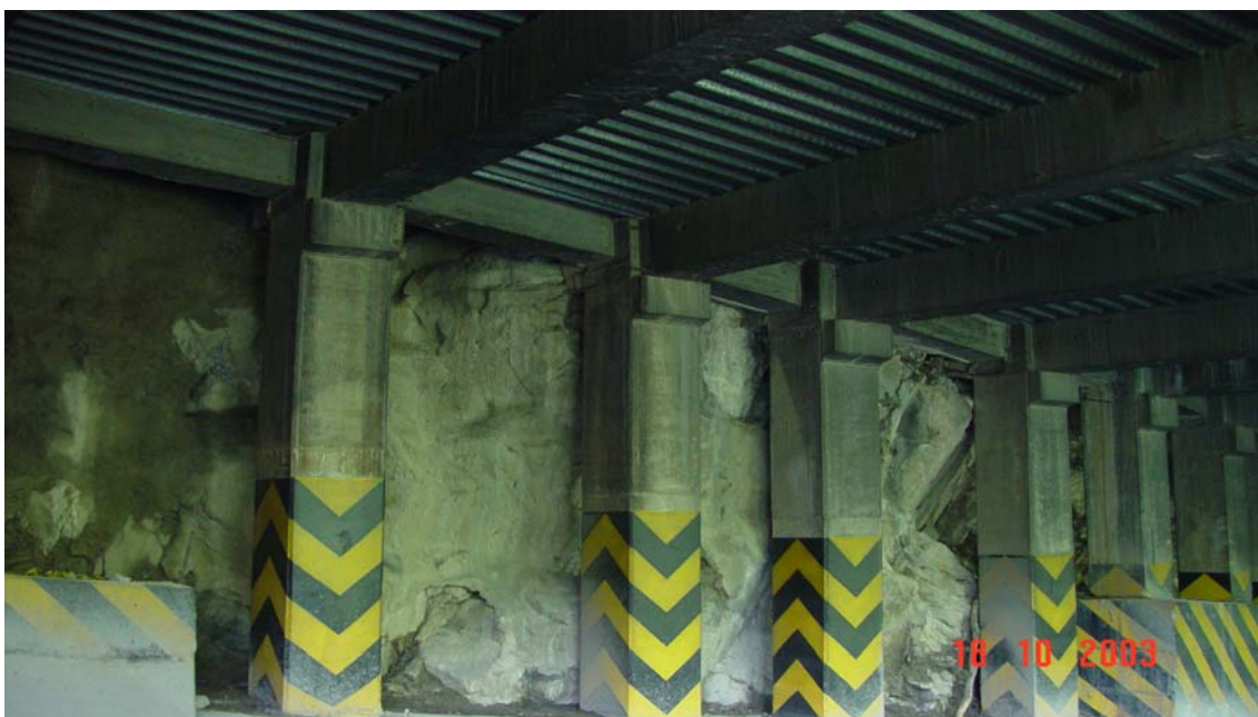
Foto 17: Columnas túneles de Quebrada blanca
