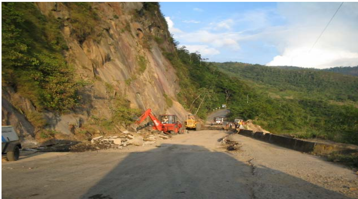
Foto 12: Levantamiento de la capa asfáltica – Túnel Falso Cerro de San Pablo
