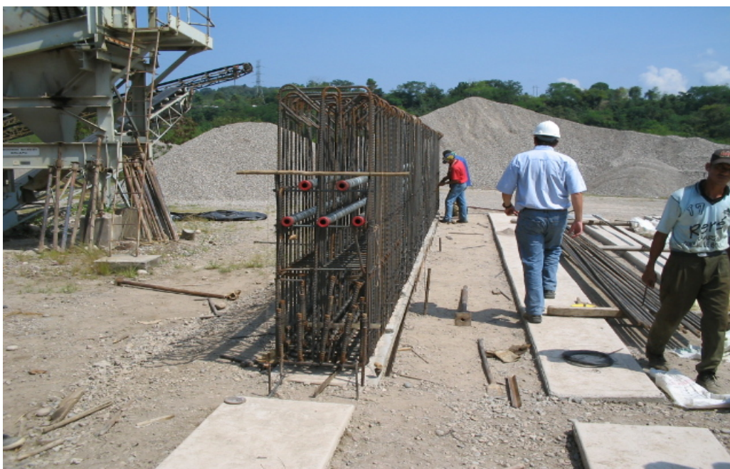
Foto 52: Armado de la primera viga prefabricada postensada VA
