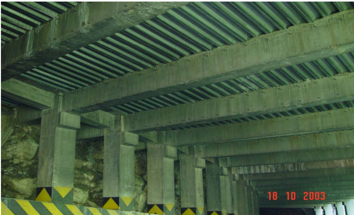
Foto 16: Vigas Túneles de Quebrada blanca
