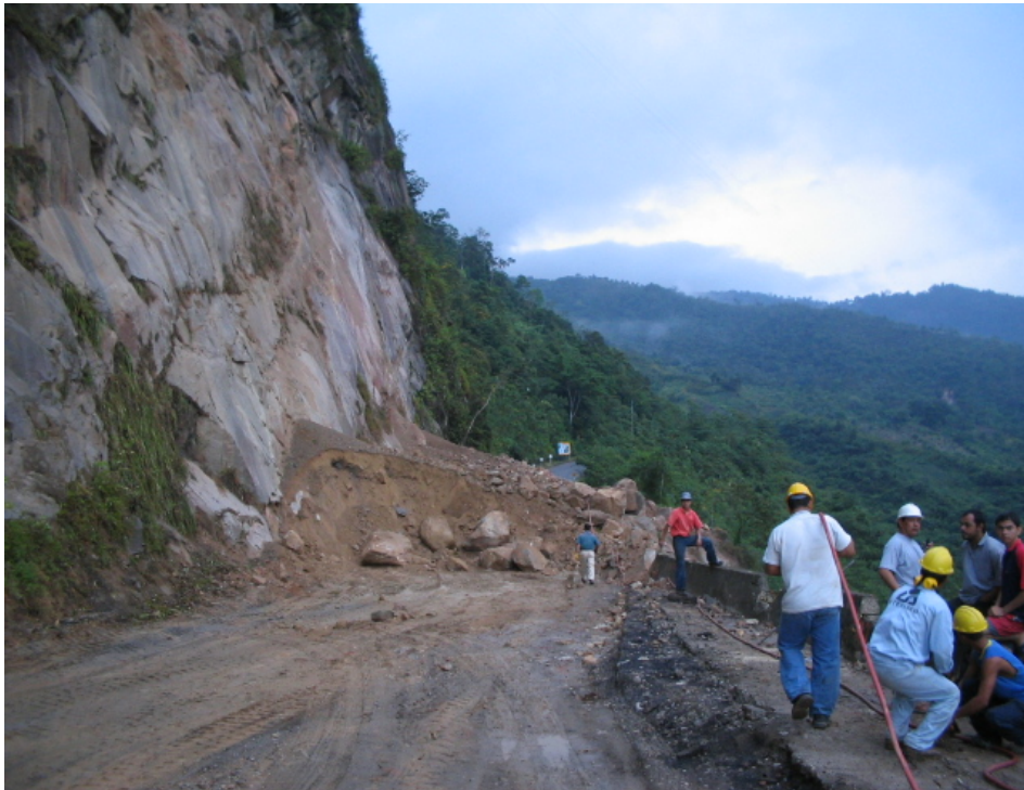
Foto 44: Escombros sobre la vía
