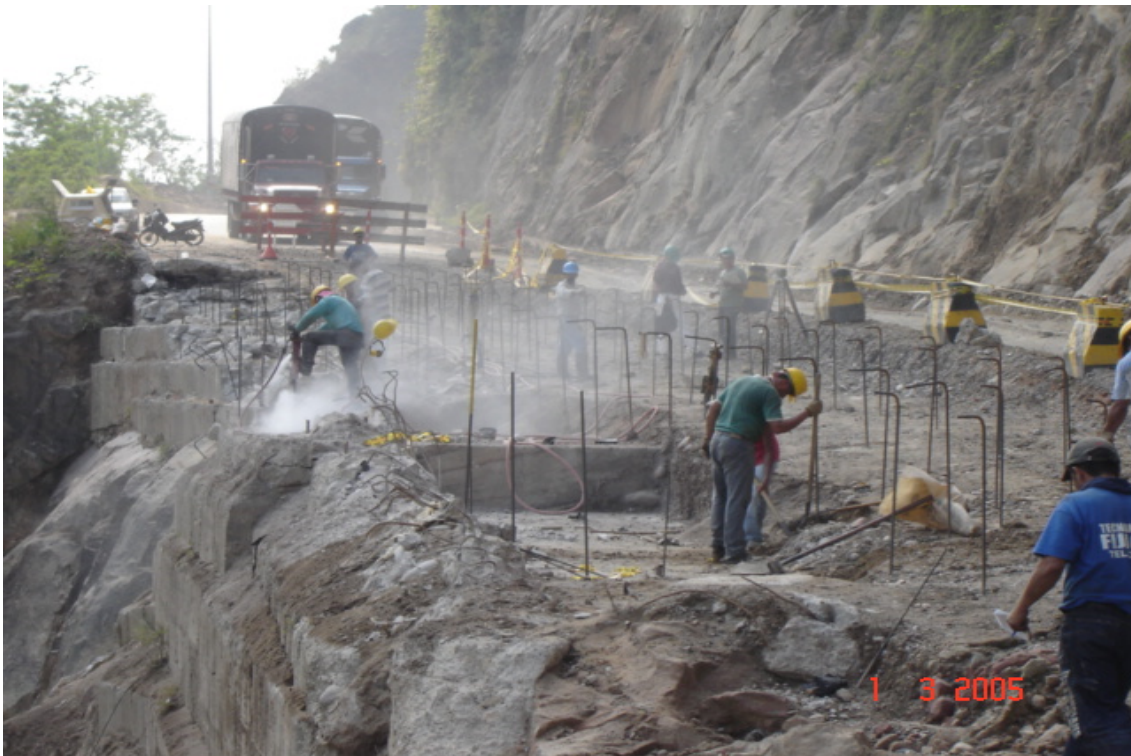
Foto 57: Proceso de instalación de anclajes- Mitad carril exterior
