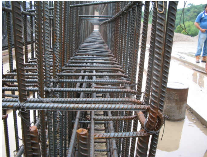
Foto 53: Detalle de refuerzo viga VA- estribos
