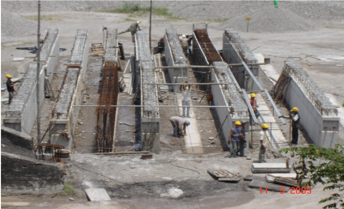
Foto 72: Vigas en proceso de Curado
