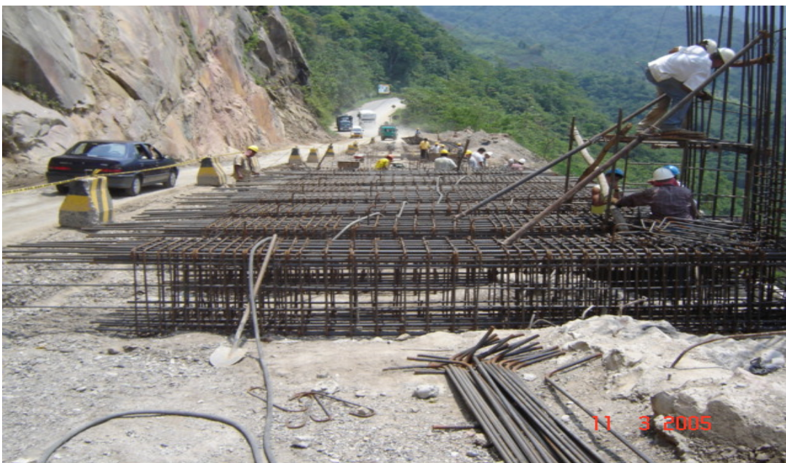
Foto 61: Armado de vigas de cimentación transversales
