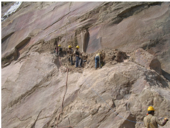
Foto 50: Instalación de los explosivos en la parte media del talud
