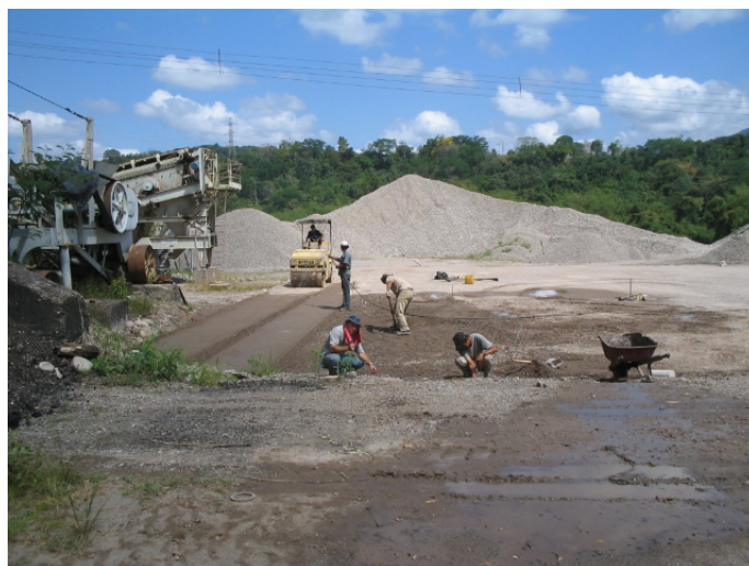
Foto 47: Adecuación del sitio donde se armarán las vigas VA
