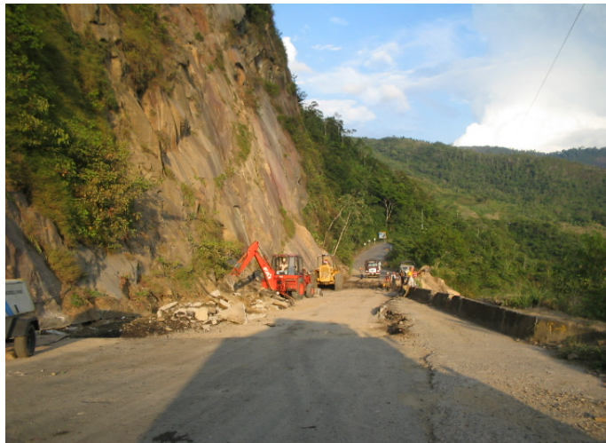
Foto 40: Remoción de capa asfáltica
