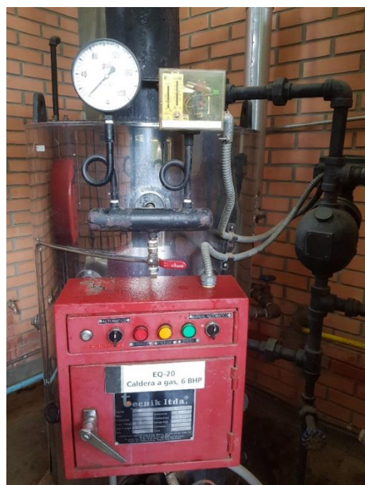
Figura 7. Equipos auxiliares e instrumentos de medición. A. Caldera de 6 BHP (TECNIK, Bogotá); B. Torre de enfriamiento (PROTON, Bogotá); C. Válvula mecánica auto pilotada de diafragma y resorte; D. Termocupla 0-250 °F (-17,8-121 °C); E. Manómetro análogo 0-15 psi (0-103421 Pa) y termómetro de carátula 0-150 °C. Complejo agroindustrial piloto CENIVAM, UIS.
