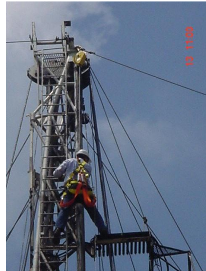
Figura 5. Línea de vida Auto-retráctil con cable de acero -Instalación en Torre
