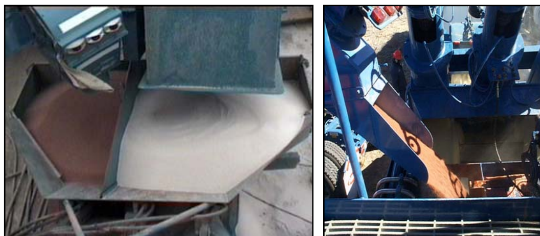
Figura 103. Batea de mezcla del material de soporte con el fluido fracturante y aditivos
