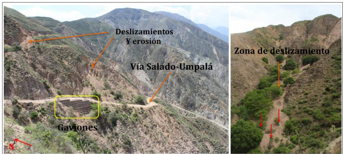
Figura 31. Deslizamientos y obras de mitigación tipo gaviones, a lo largo de la vía Salado-Umpalá.
