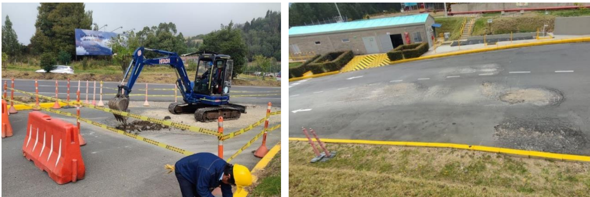
Figura 23 Rehabilitación del pavimento Planta Boyacá
