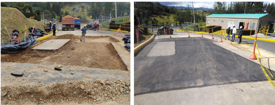
Figura 24 Proceso de construcción del pavimento Planta Boyacá
