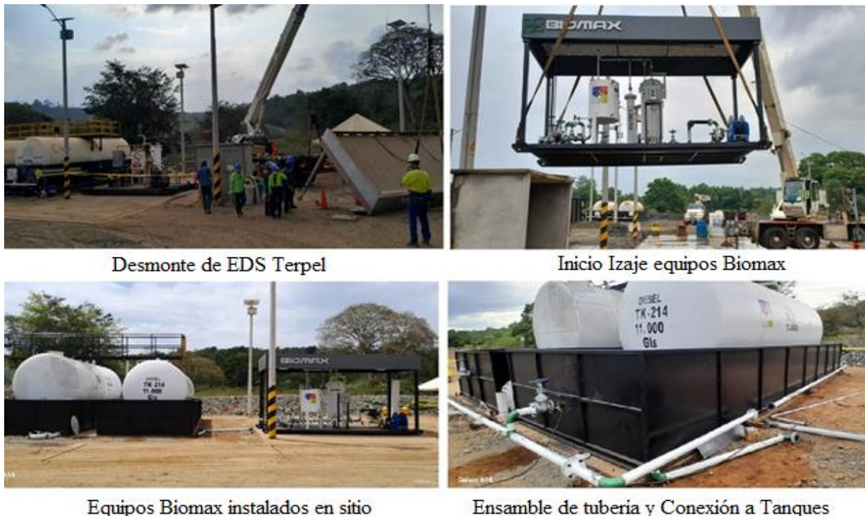
Figura 19 Ejecución de proyecto a la empresa Cerromatoso S.A.
