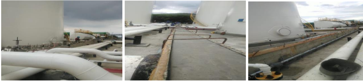
Figura 32 Construcción de muro recinto de tanques
