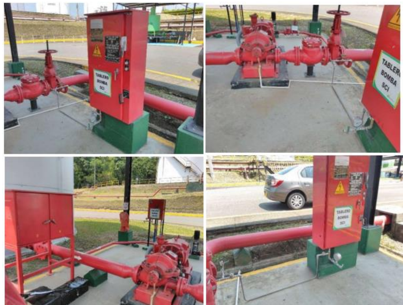
Figura 28 Cambio del tablero del SCI Planta Pereira
