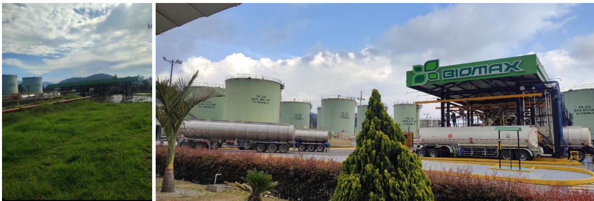
Figura 5 Visitas Técnicas Planta Mansilla
