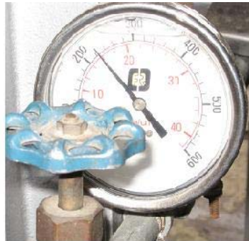
b) Presion de prueba entregada por la bomba hidraulica.
