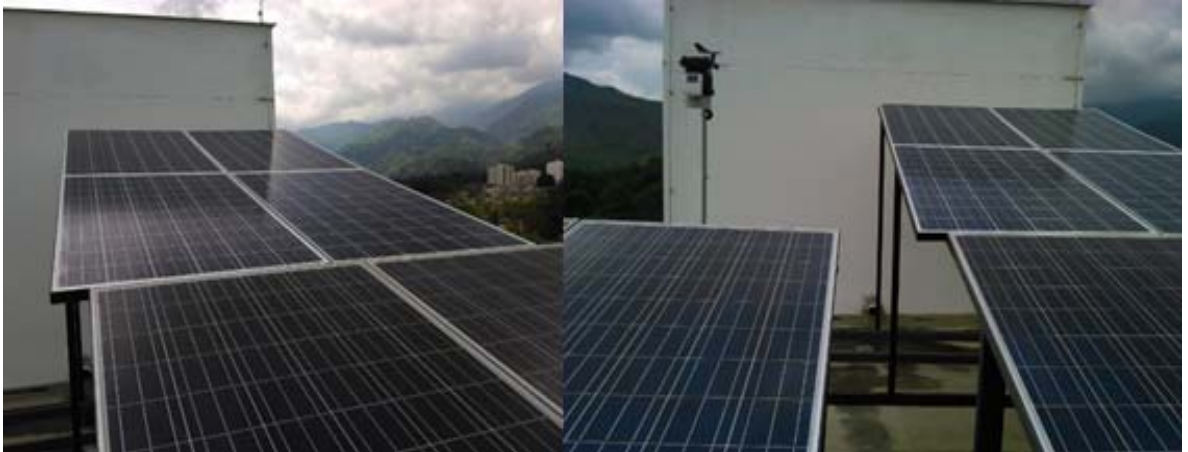
Ilustración 20. Paneles fotovoltaicos.
