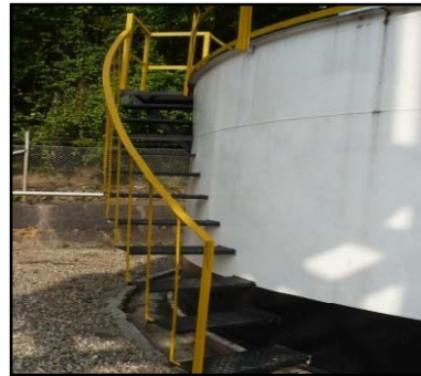
11 b) Escaleras tanque K-02
