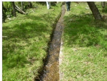
Imagen 5: Canal de toma.
