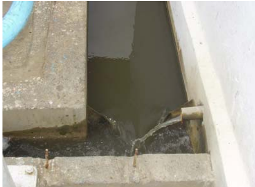
Fig. 8 Mezcla Rápida
