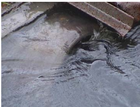
Fig. 3. Rebose desarenador
