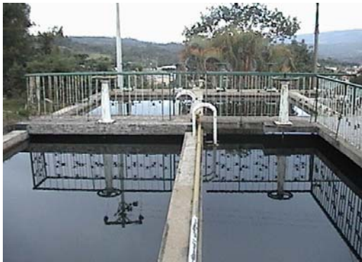
Fig. 11 Sedimentadores convencionales
