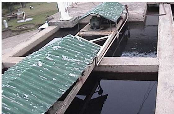
Fig. 10 Floculadores Mecánicos
