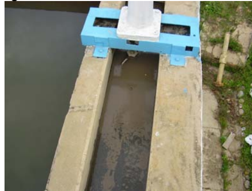
Fig. 12 Canal entrada al sedimentador
