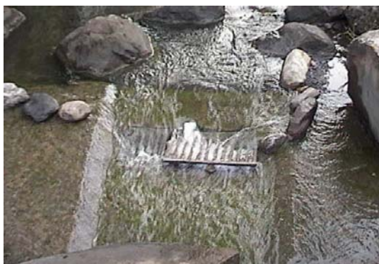
Fig. 2 Bocatoma de fondo
