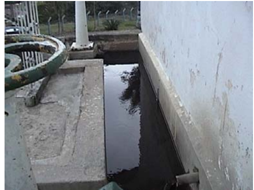
Fig. 9 Canal de entrada
