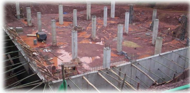
Figura 16. Avance construcción Centro Logístico FCV
