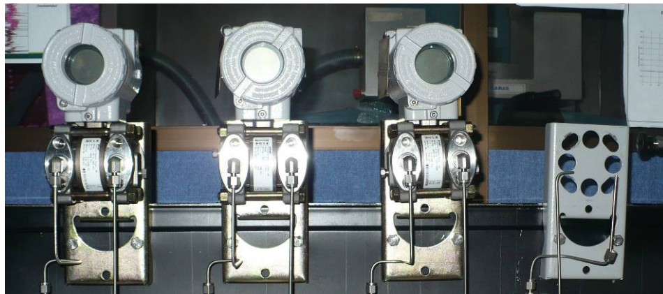
Figura 85 Montaje De Los Medidores De Presión Diferencial
