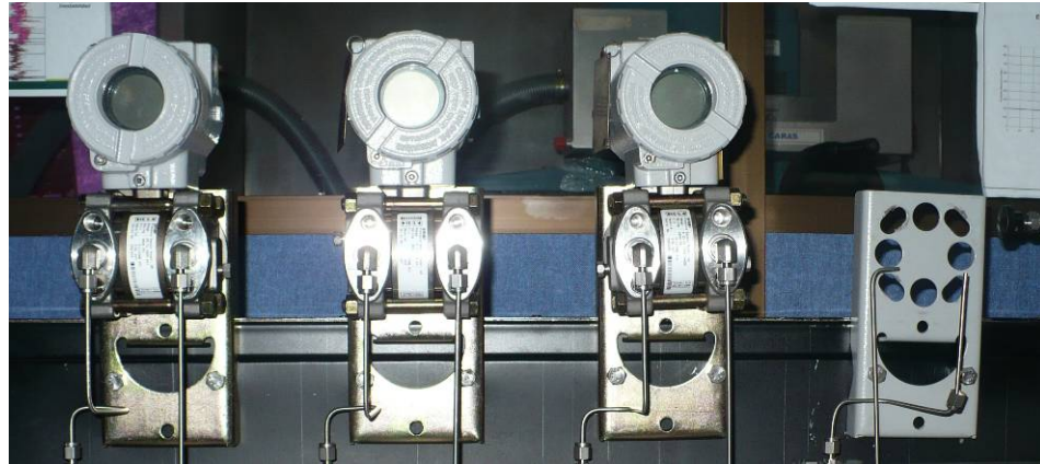
Figura 37 Detalles Montaje De Los Medidores De Presión Diferencial
