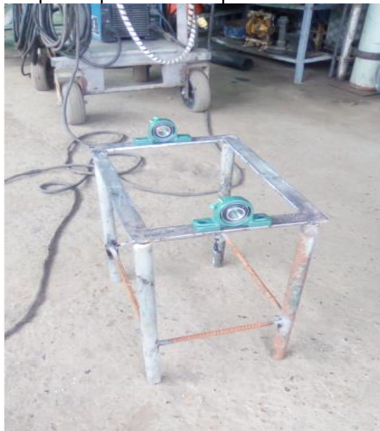
Figura 46. Instalación de soportes para evitar separación
