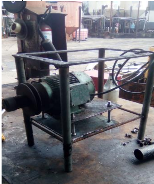
Figura 47. Instalación del soporte para el motor
