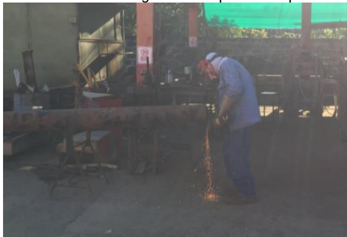
Figura 39. Corte de la tubería con la longitud correspondiente para el cilindro
