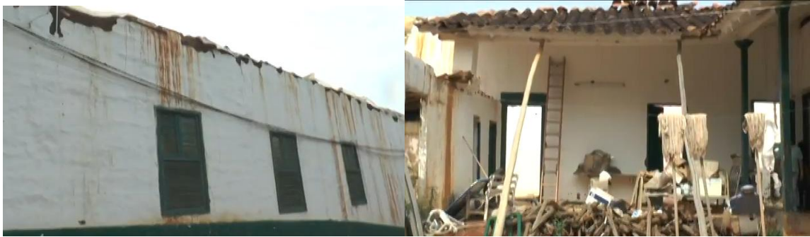
Figura 17 Condiciones actuales del hospital.
