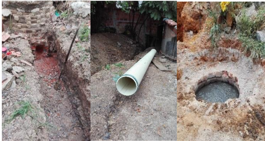
Figura 9 Registro fotográfico del 24 de agosto del 2016.
