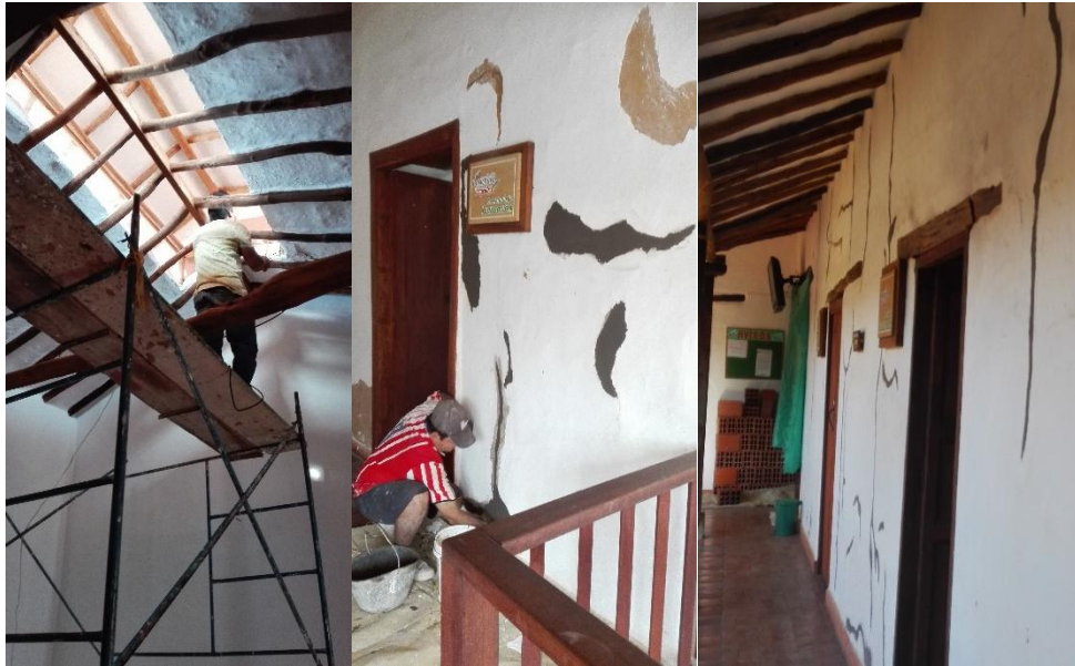
Figura 15 Registro fotográfico del 28 de agosto del 2016.
