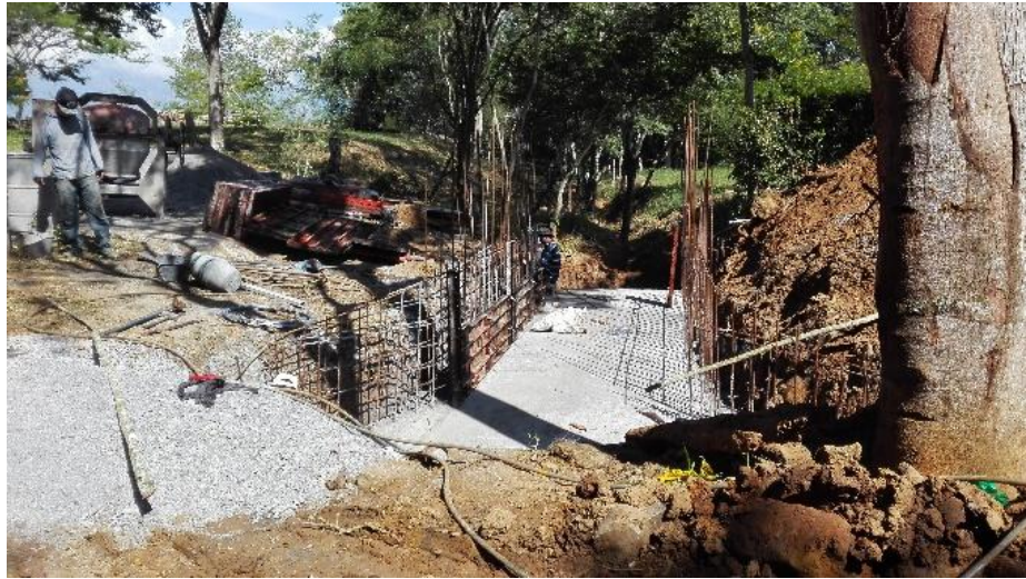
Figura 12 Registro fotográfico del 19 de agosto del 2016.
