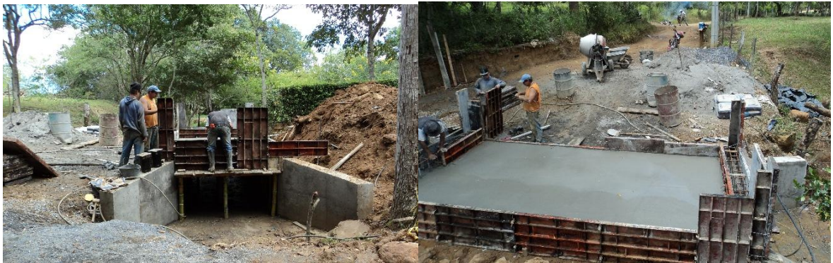
Figura 13 Registro fotográfico del 26 de agosto del 2016.
