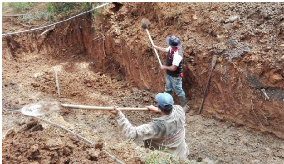
Figura 11 Registro fotográfico del 12 de agosto del 2016.
