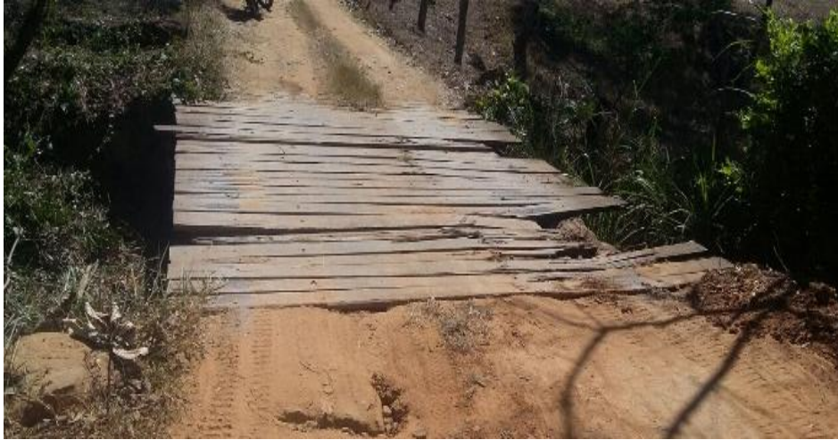
Figura 10 Registro fotográfico del 01 de agosto del 2016.
