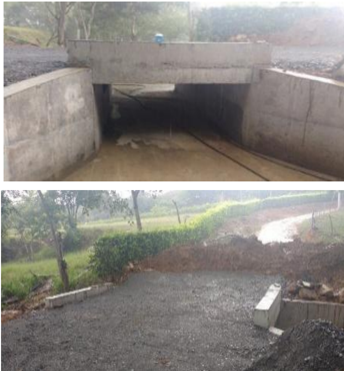
Figura 14 Registro fotográfico del 31 de agosto del 2016.
