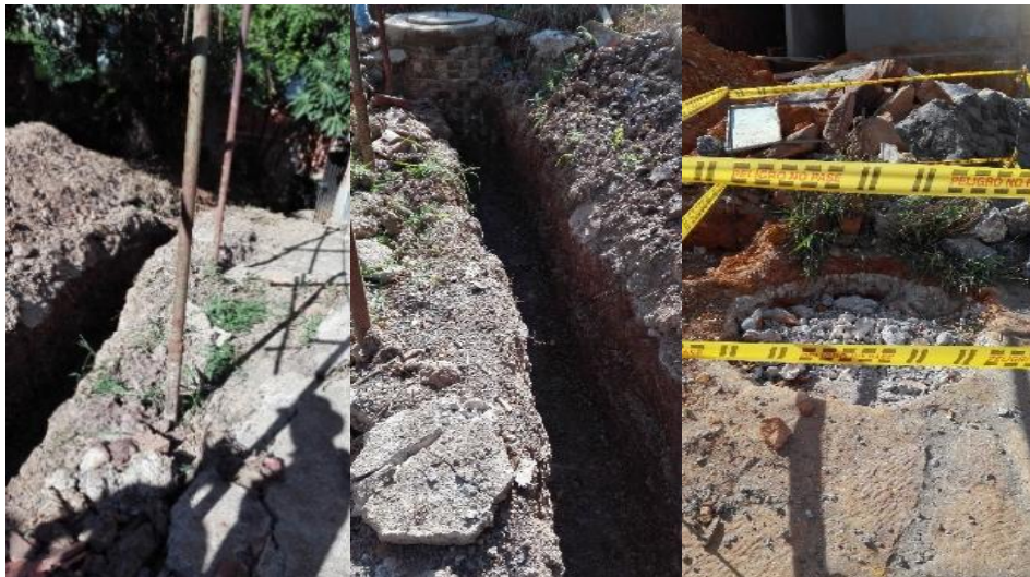
Figura 8 Registro fotográfico del 19 de agosto del 2016.
