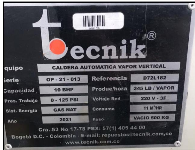
De acuerdo con esta placa, se infiere que la capacidad calorífica requerida en escala Biofábrica es 10 BHP. Esta capacidad debe ser llevada a la escala de la unidad funcional:
