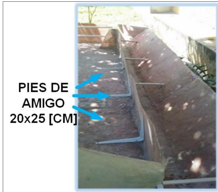
Figura 34. Pies de amigo paredes laterales casco.
