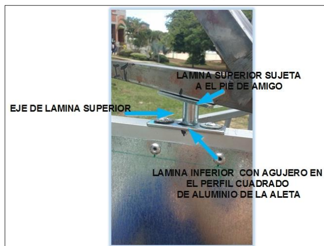
Figura 66. Láminas de sujeción a pies de amigo y aletas
