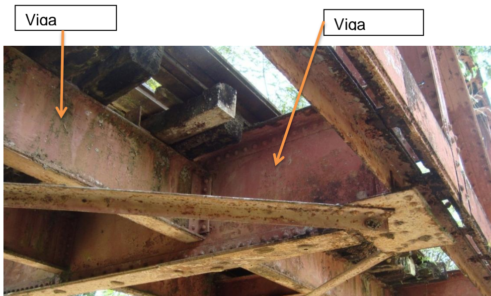
Figura 2. Elementos de un puente de estructura inferior
