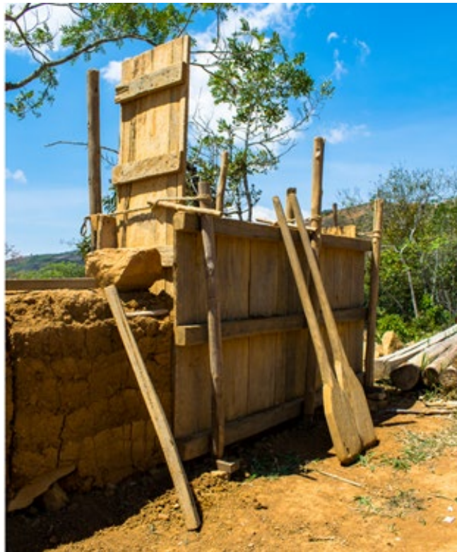
Figura 58. Fotografía de un tapial armado y un muro de tapia pisada recién hecho.
