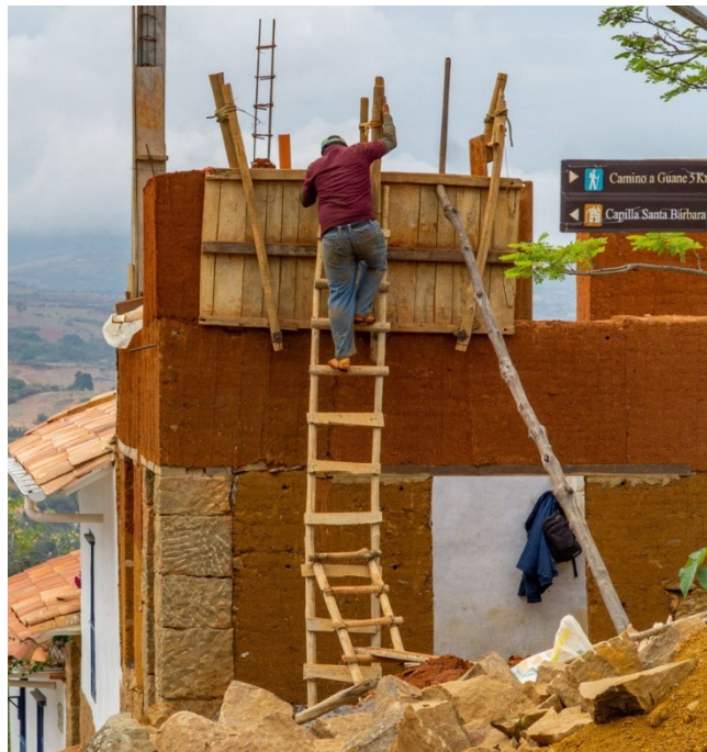
Figura 15. Construcción tapia pisada.
