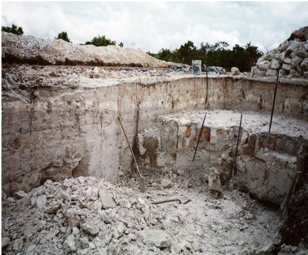
FIGURA 14. Frente de explotación S11 previamente descapotado.
