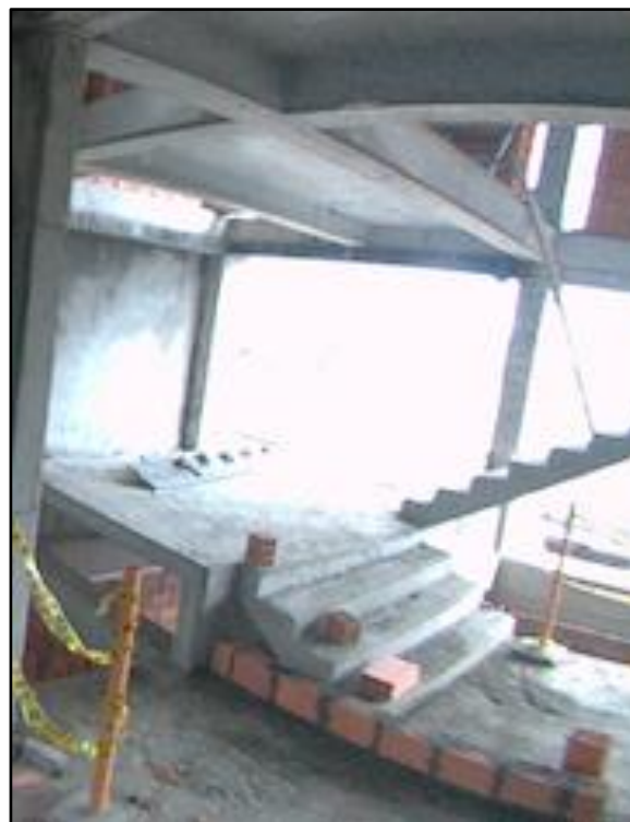
Figura A17.1 Avance del ítem correspondiente a las escaleras tipo 4. Fuente: Camara de 360 grados del grupo de investigacion Geomatica.
