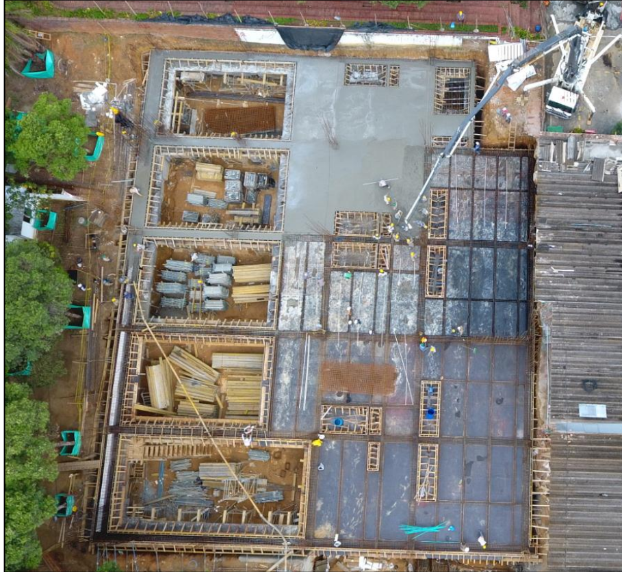
Figura A10.1 Avance del item correspondiente a las placas de entre piso. Fuente: Registrado por medio de un UAV del grupo de investigacion de Geomatica.
