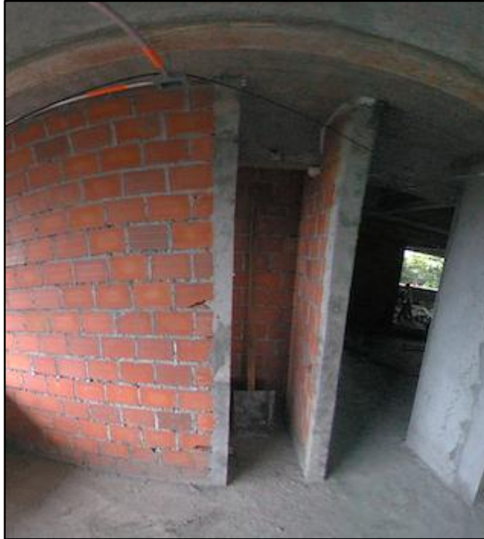
Figura A23 .1Avance del item correspondiente a las columnetas de confinamiento. Fuente: Camara de 360 grados del grupo de investigacion Geomatica.
