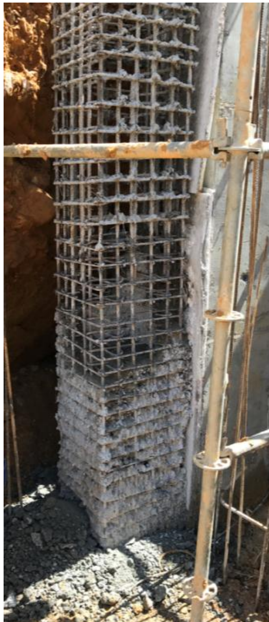
Figura 67A.1. Demolicion de columna 3J. Fuente: Autor.
