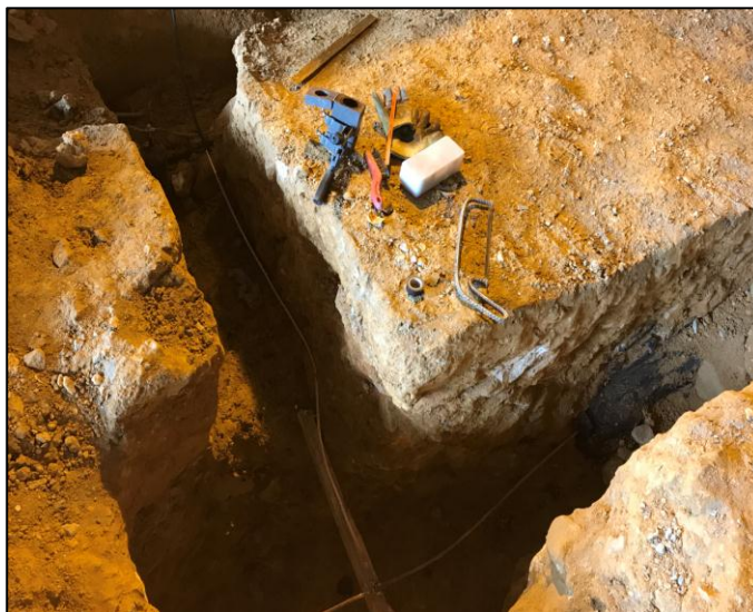
Figura A.6.1 Avance del ítem correspondiente a las zapatas. Fuente: Cámara de alta definición.
