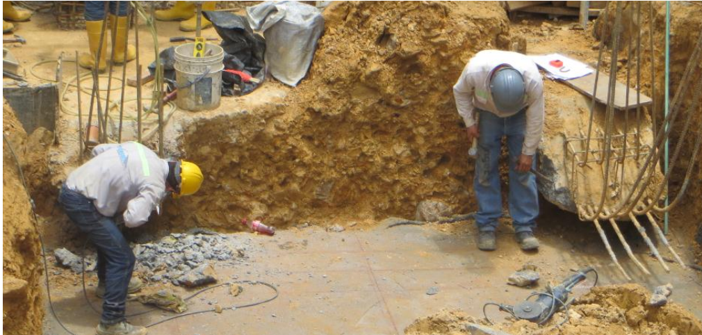
Figura 67A.2 Demoliciones en el modulo 2. Fuente: Autor
