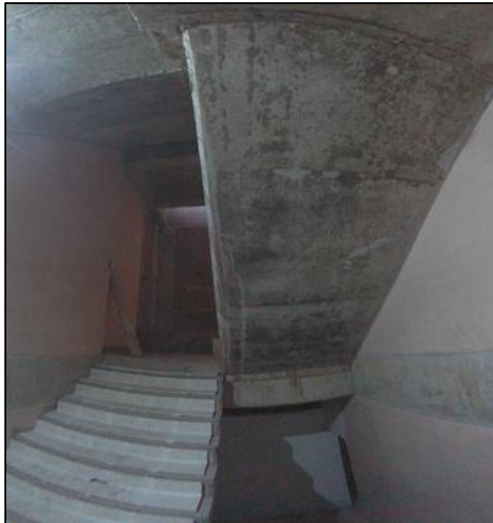
Figura A15.1 Avance del ítem correspondiente a las escaleras tipo 2. Fuente: Cámara de 360 grados del grupo de investigación Geomatica.
