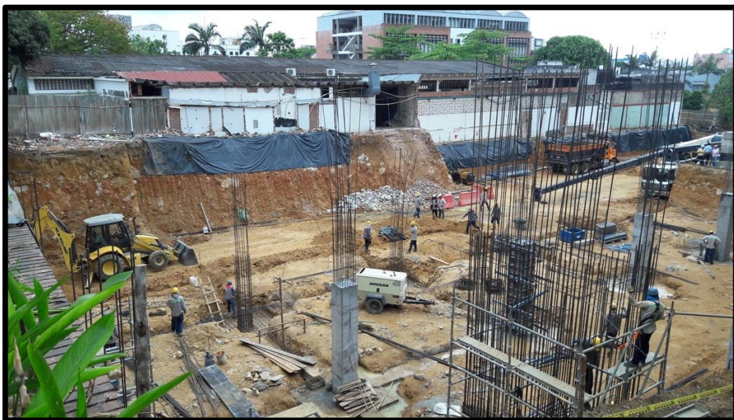
Figura 67A.7 Demoliciones de la edificacion ubicada en el fondo. Fuente: Autor
