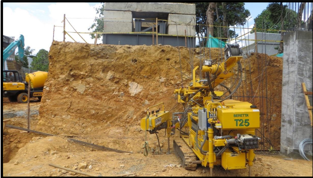
Figura 67A.6 Instalacion de anclajes. Fuente: Autor
