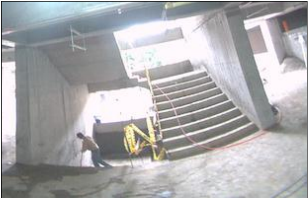
Figura A14.1 Avance del item correspondiente a las escaleras tipo 1. Fuente: Camara de 360 grados del grupo de investigacion Geomatica.
