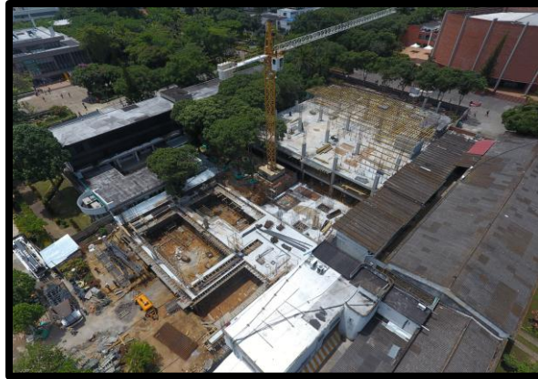
Figura 3. Imagen aérea posterior a la fundición de la placa N+0.00 del módulo 1. Fuente: dron del grupo de investigación Geomatica
