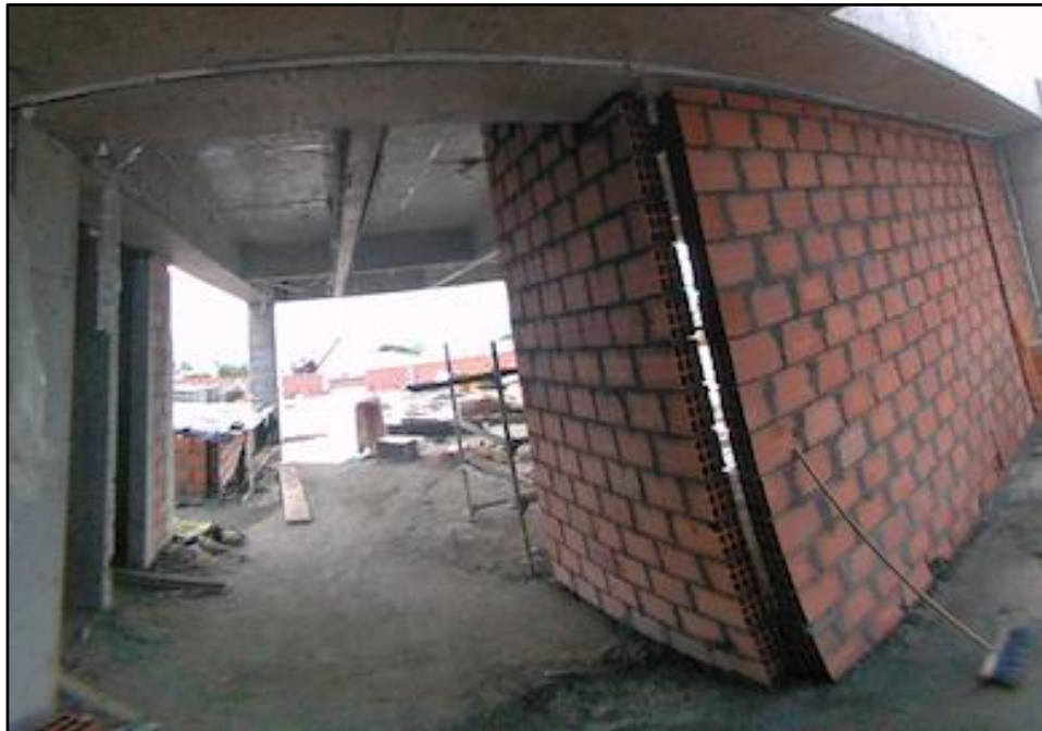
Figura A20.1 Avance del item correspondiente a los muros de mamposteria H-12. Fuente: Camara de 360 grados del grupo de investigacion Geomatica.
