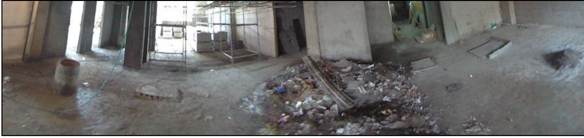
Figura A12.1 Avance del ítem correspondiente a las placas de contrapiso de 10cm de espesor. Fuente: Cámara de 360 grados del grupo de investigación Geomatica.
