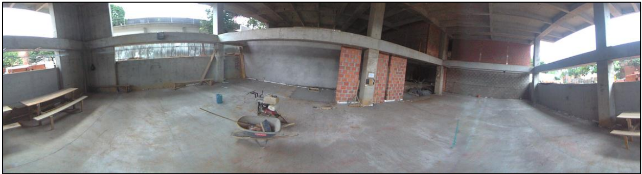
Figura A11.1 Avance del item correspondiente a las placas de contrapiso de 10cm de espesor.
