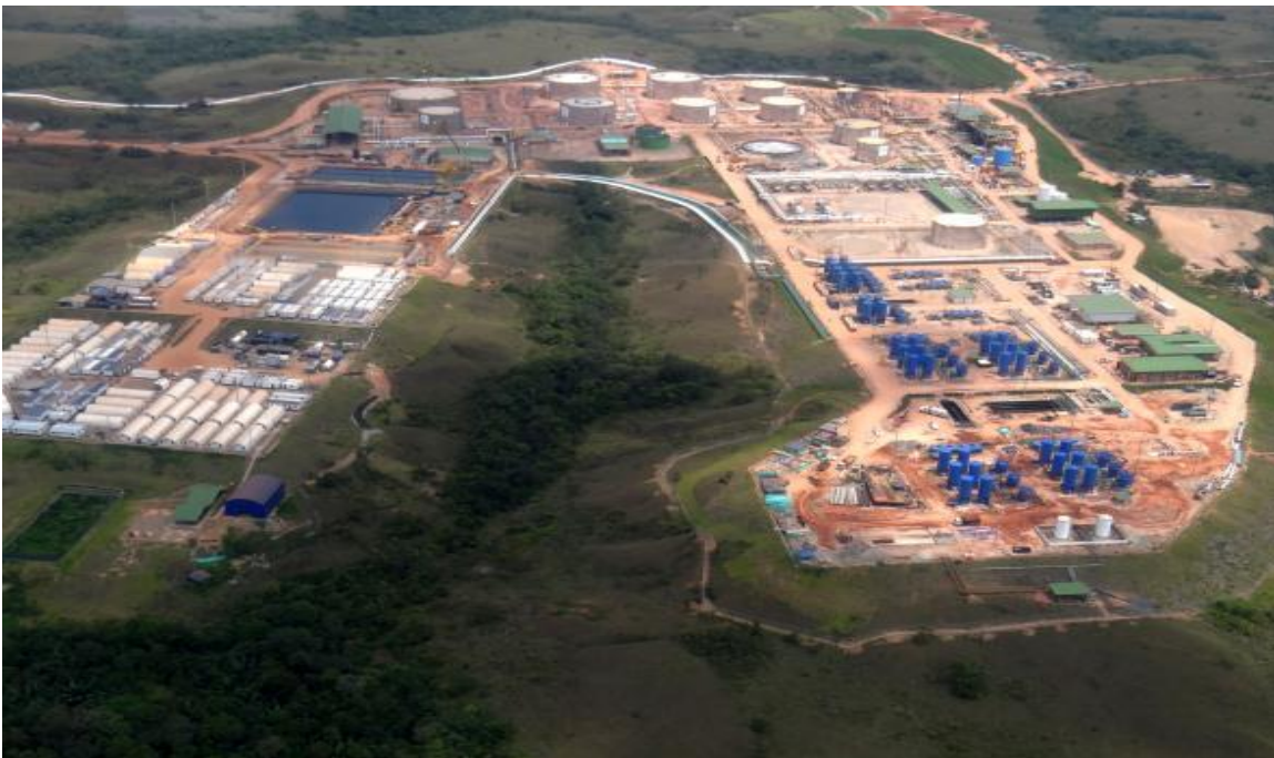
Figura 5: Instalación típica para la separación de crudo. Fuente: Leonardo Salguero
