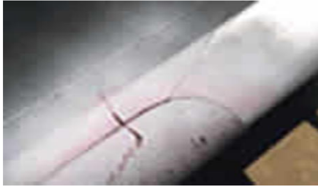
Figura 21: Fallas detectadas por la técnica de líquidos penetrantes. Fuente: www.google.com.co /imagenes ensayos no destructivos
