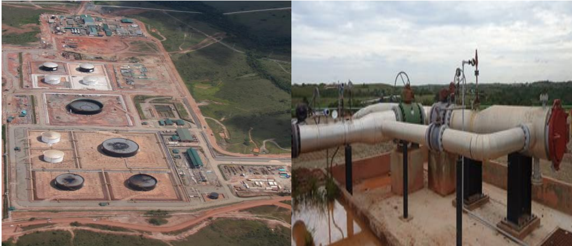
Figura 9: Estación de bombeo y oleoducto para el transporte de crudo. Fuente: Ilvar Vanegas
