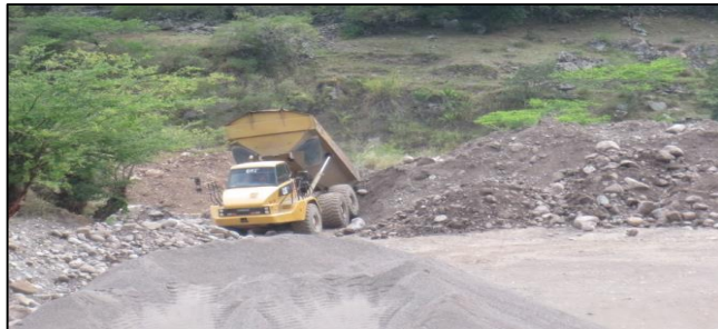
Figura 4. Acopio de material
