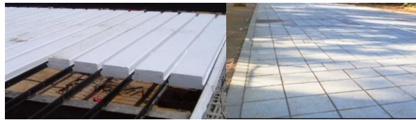
Imagen 20. Losas Prefabricadas
