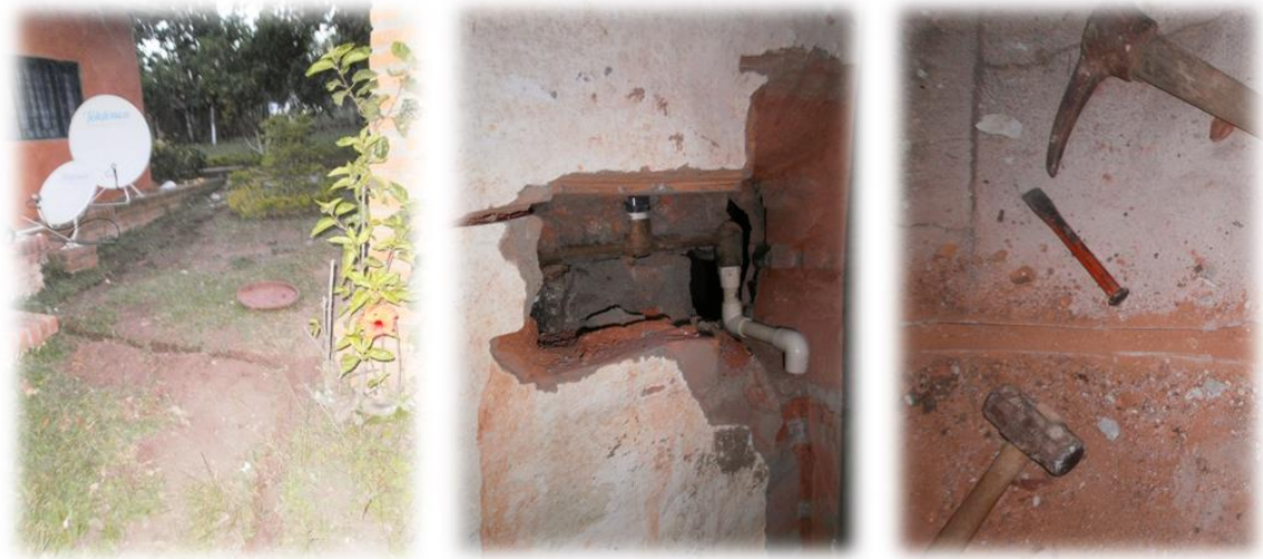
Figura 85. Instalación del subsistema hidráulico
