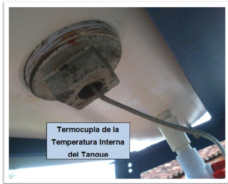
Figura 91. Ubicación termocupla temperatura interior del tanque
