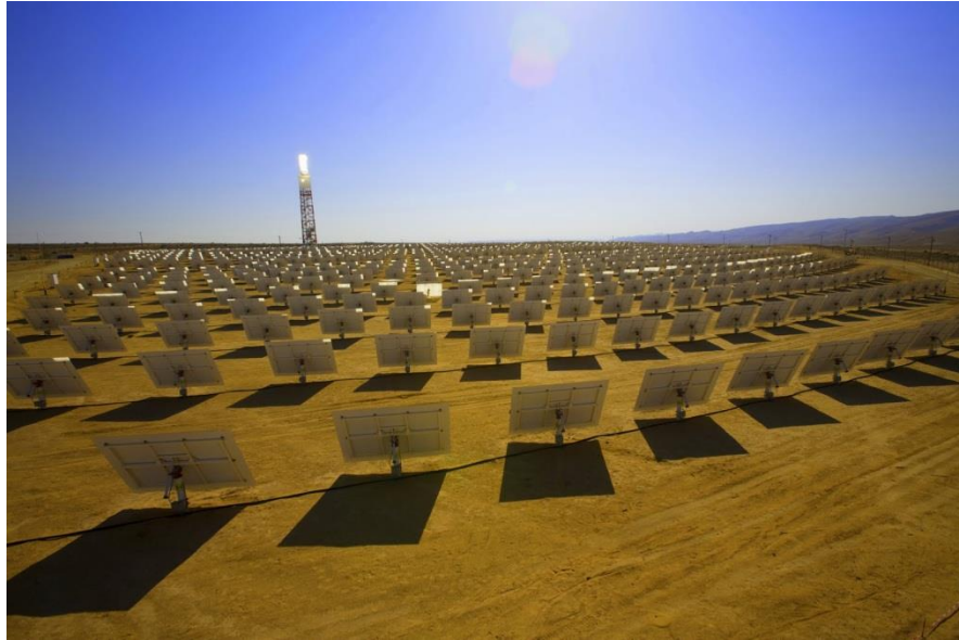
Figura 1. Central solar de colectores planos
