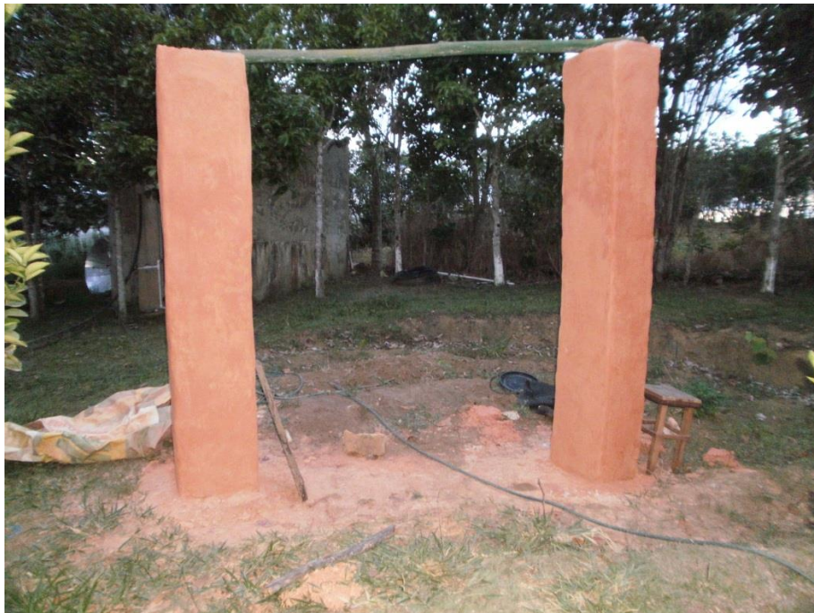
Figura 81. Columnas en ladrillo de tierra.
