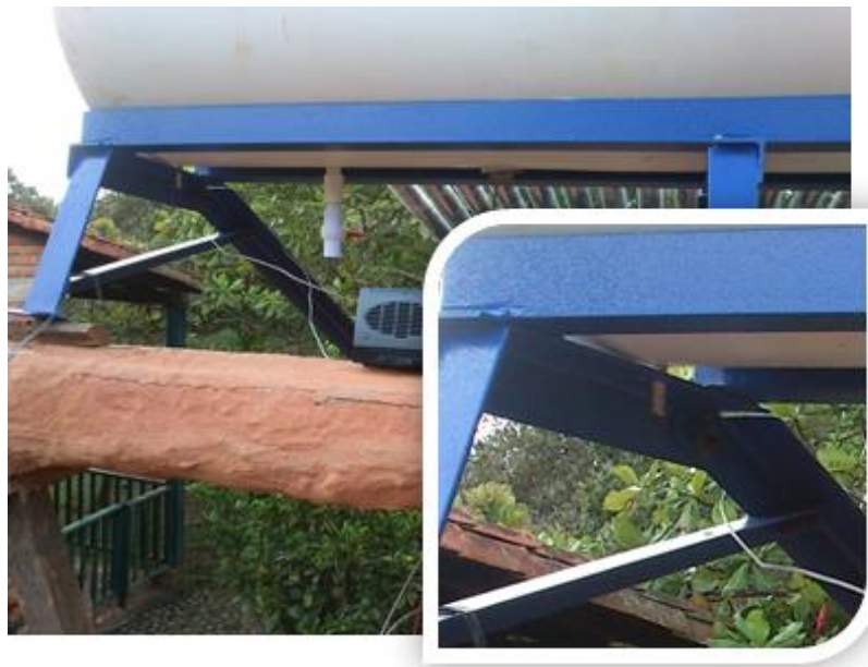
Figura 83. Instalación del tanque
