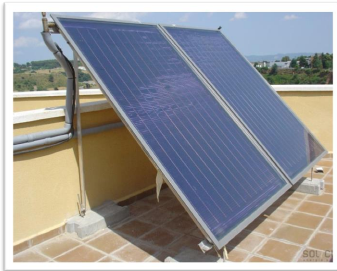
Figura 34. Colector solar de placa plana para uso residencial
