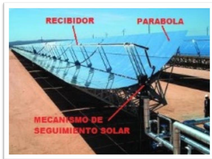
Figura 37. Colector solar cilíndrico parabólico
