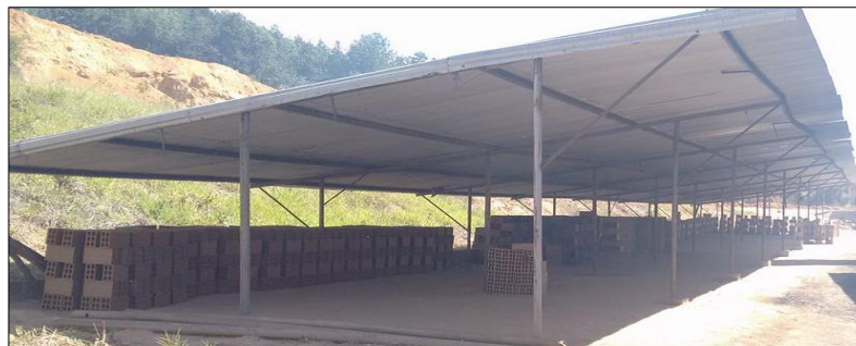
Imagen 30. Zona de almacenamiento 3. Ladrillo H10.
