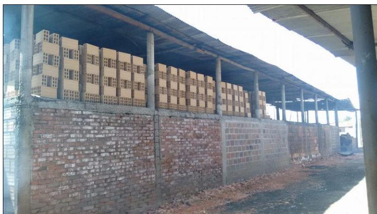
Imagen 29. Zona de almacenamiento 2. Techo túnel de secado.
