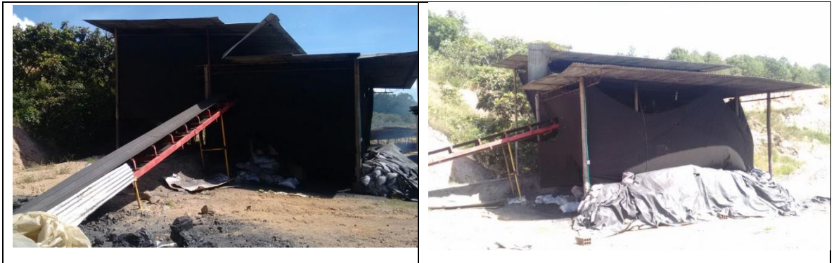
Imagen 23. Zona de molienda de carbón.
