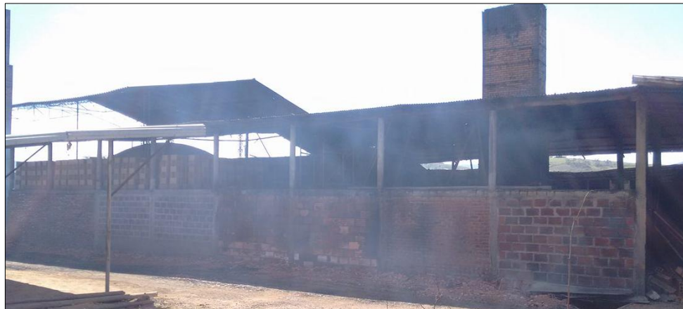
Imagen 28. Zona de almacenamiento 1. Túnel de secado H10
