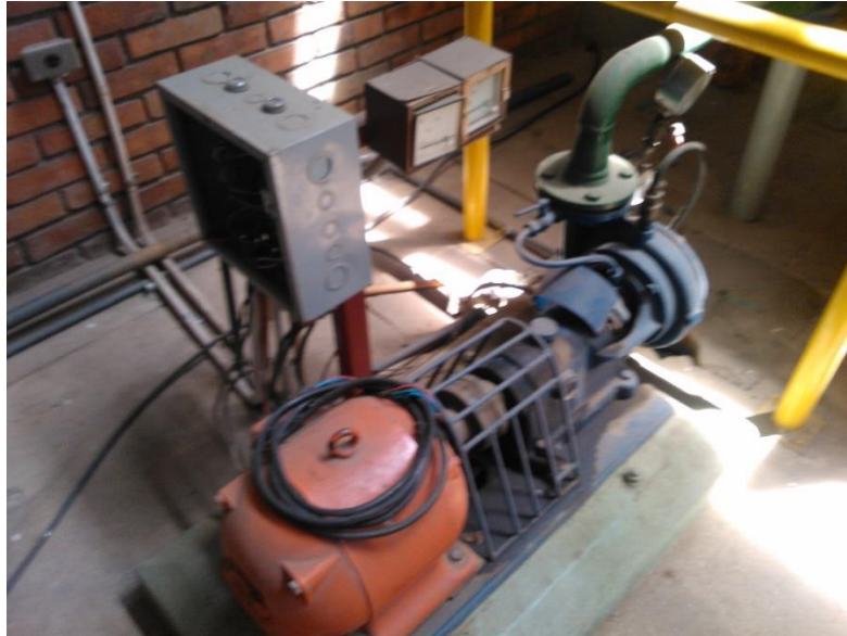
Figura 68 Sub-ensamblaje bomba centrifuga.
