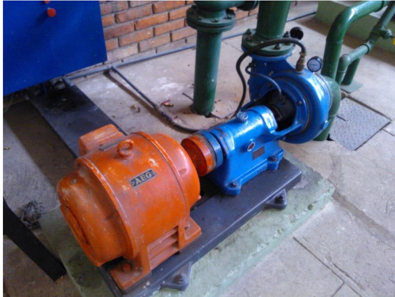
Figura 51 Sub-ensamblaje bomba centrifuga.
