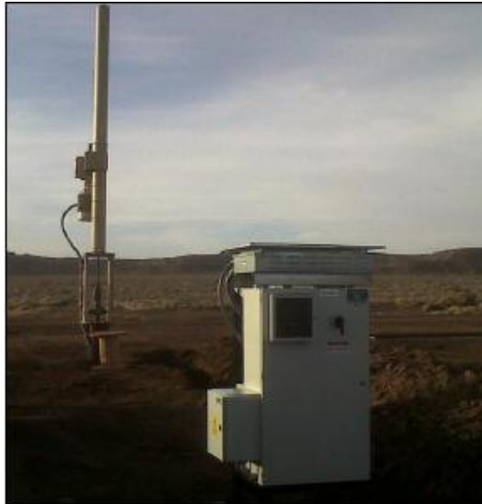
Figura 23. Controlador de la unidad LRP (Driver)
