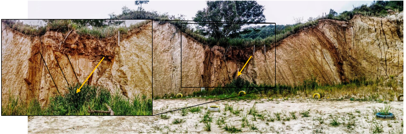
Figura 29. Evidencia de fallamiento normal encontrada en la estación E121.
