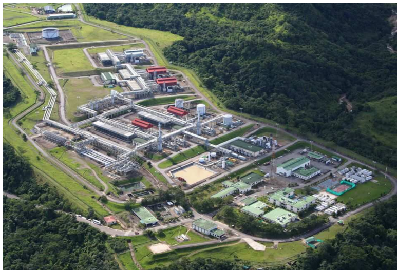
Figura 4 Instalaciones Centrales de Procesamiento (CPF) Cupiagua.
