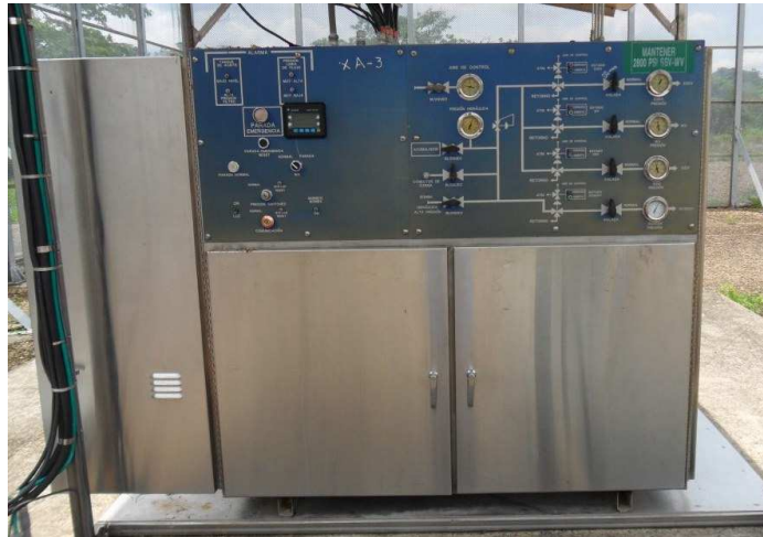
Figura 14 WHCP de un Pozo productor de petróleo Cupiagua
