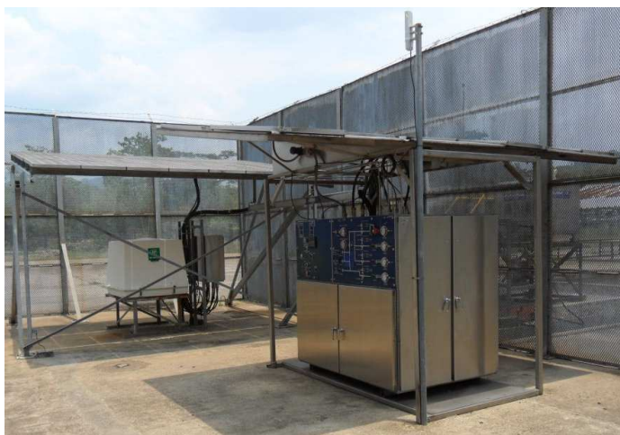
Figura 13 WHCP de un Pozo productor de petróleo Cupiagua
