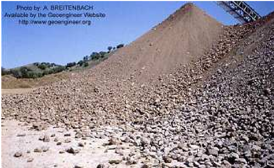
Fotografía 1.1. Segregación de los agregados al extenderse el material.
