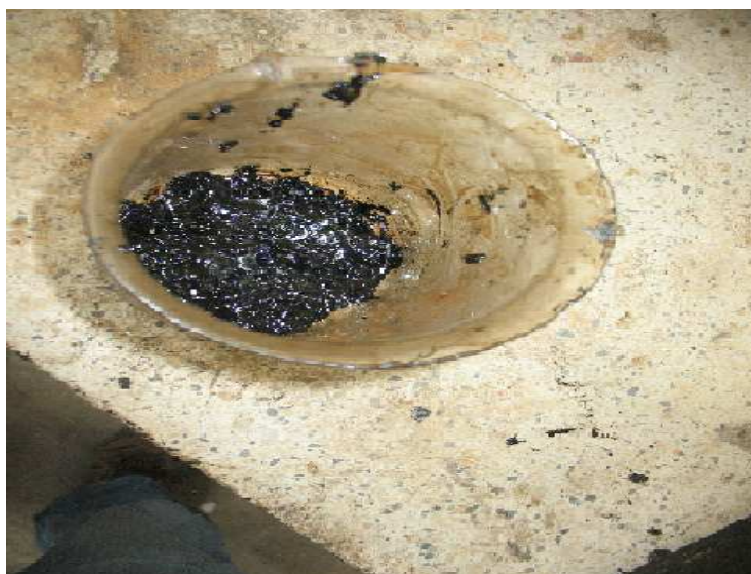
Figura 14. Escurrimiento de la mezcla.
