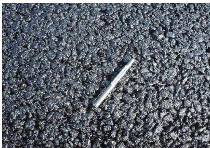
Figura 3. SMA construido en el terreno.
