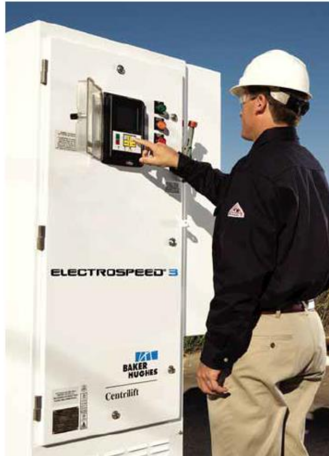
Figura 3 Variador de Velocidad
