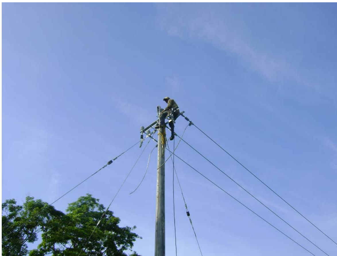
Fotografía 18 Tendido Final de la línea
