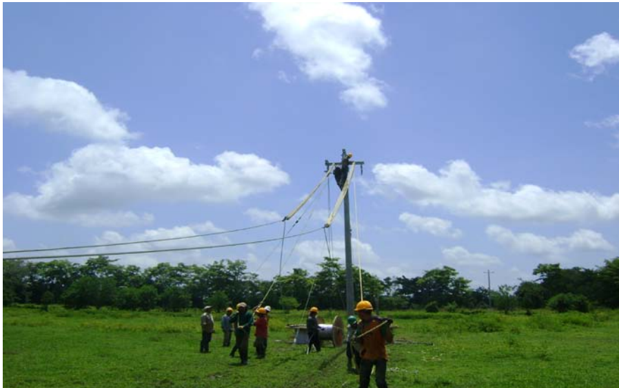
Fotografía 13 Tendido de conductores
