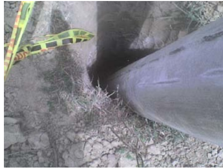
Foto 1 Apoyo Hincado En La Cepa
