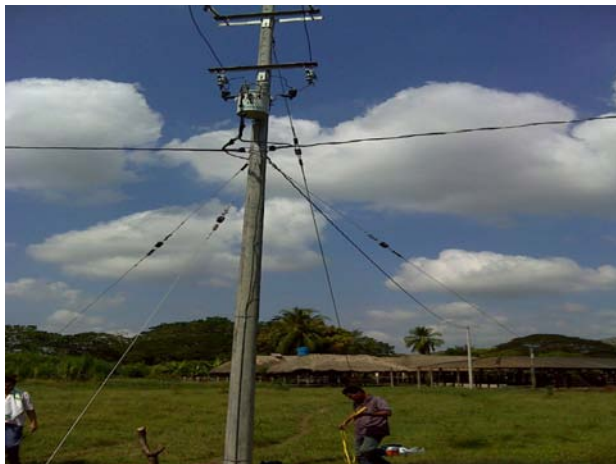
Foto 21 Dps en transformadores
