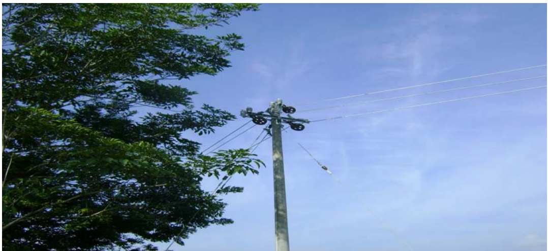
Fotografía 15 Poleas En El Templado De Conductores
