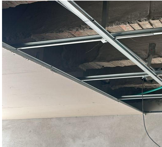
Figure 15. Montaje de lámina sin traba.
