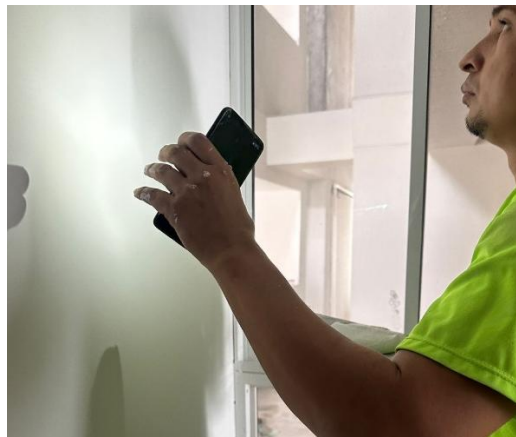
Figure 17. Inspección visual con luz directa
