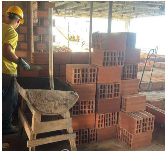
Figure 3. Mampostería proyecto Golden Tower
