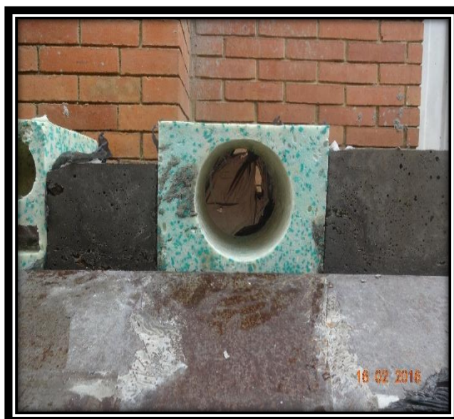
Imagen 18. Desencofrado de casetón
