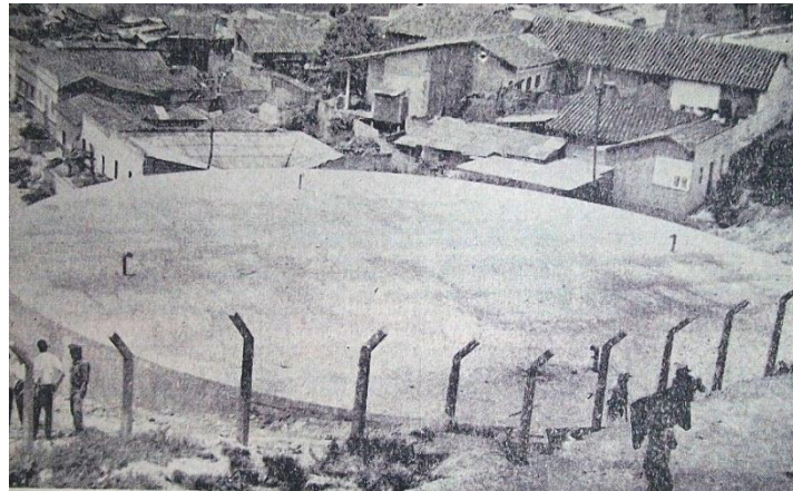
Fotografía 12. Tanque de abastecimiento de agua potable en Villabel.
