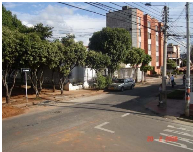
Fuente. Acueducto Metropolitano de Bucaramanga
