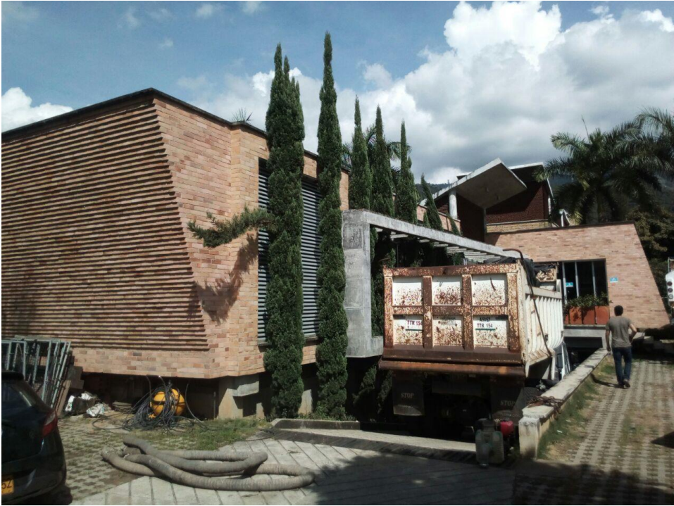
Figura 4. Toma interna sede principal D Ingeniería.
