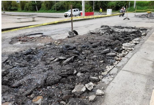
Figura 3. Corte de pavimento realizado por el contratista Diapofy S.A.S, sobre la Cra. 8, Frente a la Bodega de la Panela.
