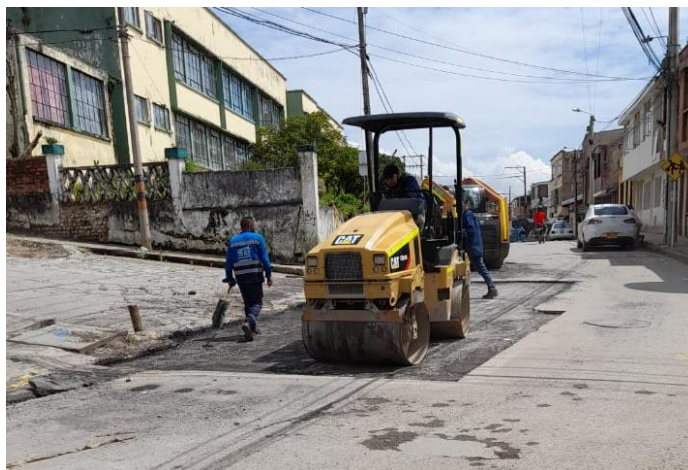
Figura 4. Compactación de material granular por parte del contratista Diapofy S.A.S, sobre la Cra. 9.
