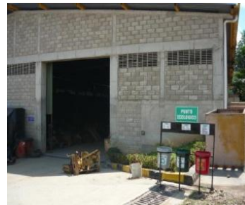
Foto 59. Punto ecológico bodega sede servicios técnicos
