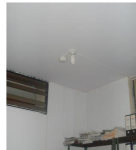
Foto 42. Sensor de movimiento control de iluminación en áreas
