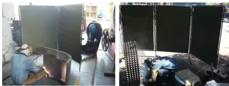
Foto 53. Puesto de soldadura usando biombo
