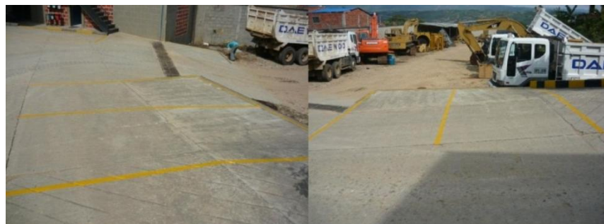
Foto 29. Demarcación parqueadero sede servicios técnicos
