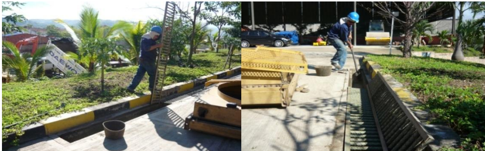
Foto 47. Limpieza de alcantarillas de recolección de aguas residuales
