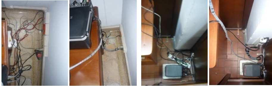
Foto 68. Adecuación del cableado puesto de trabajo sede comercial
