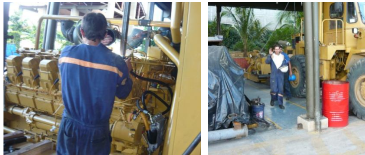
Foto 18. Evidencia inspección EPP
