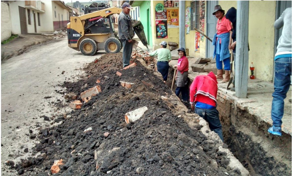
Demolición de Andenes y trabajo de la comunidad para instalación de tubería de Riego.
