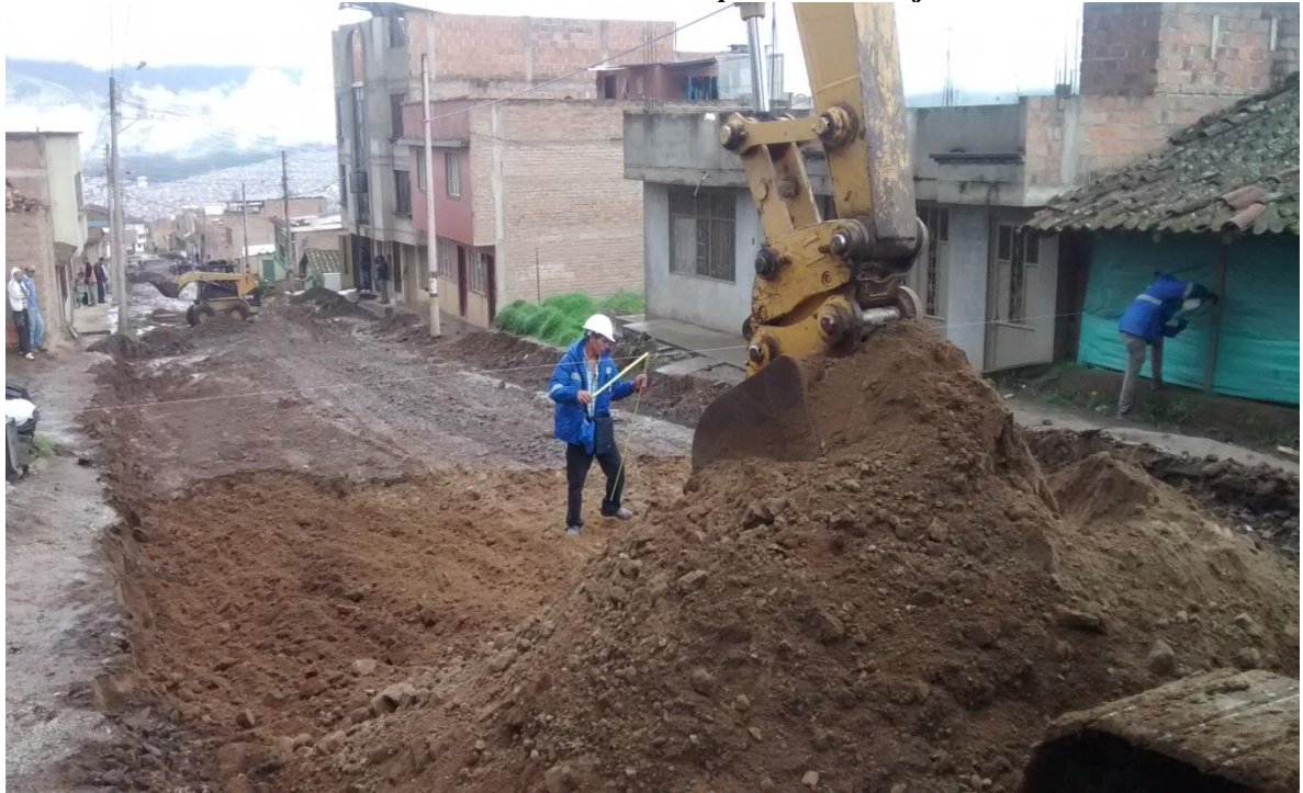
Revisión de niveles a medida que avanza el cajeo.
