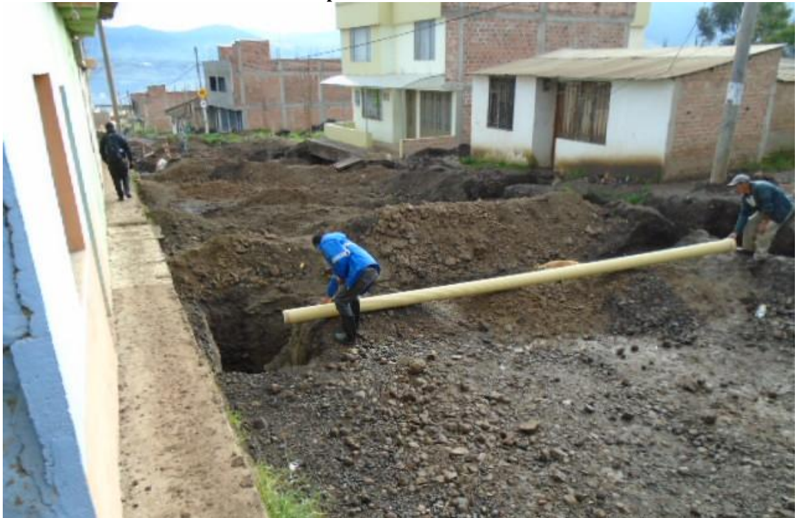
Estado de la Vía durante los trabajos de acometidas Sanitarias, fluviales y de Acueductos realizados por la comunidad.
