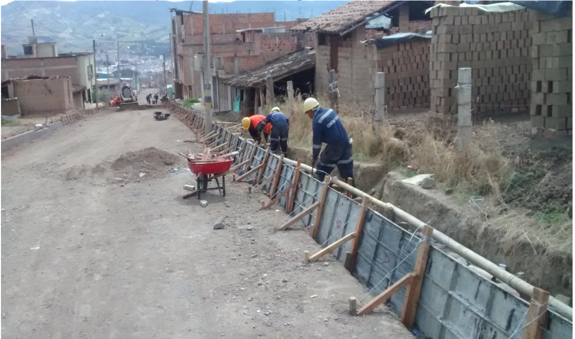
Trabajo de fundición de bordillos con mixers.
