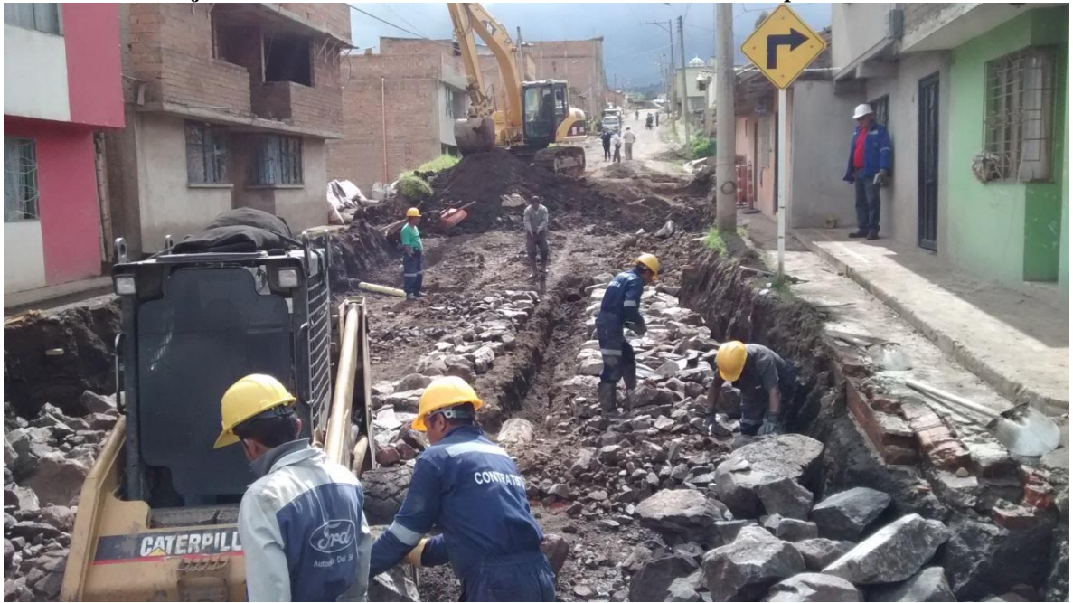
Revisión de niveles a medida que avanza el cajeo.
