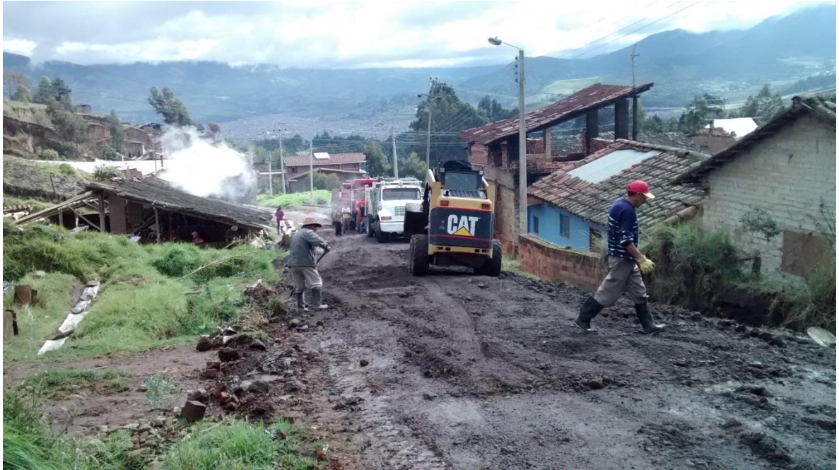
Inicio de Cajeo para Estructura de Pavimento.
