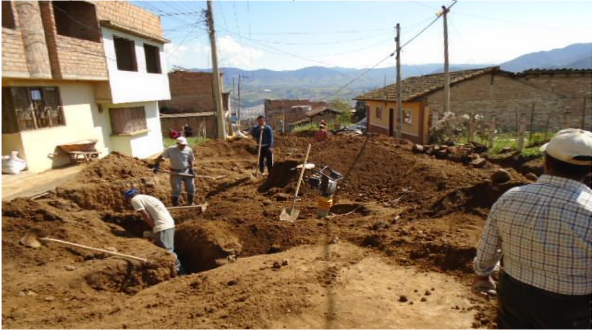
Estado de la Vía durante los trabajos de acometidas Sanitarias, fluviales y de Acueductos realizados por la comunidad.
