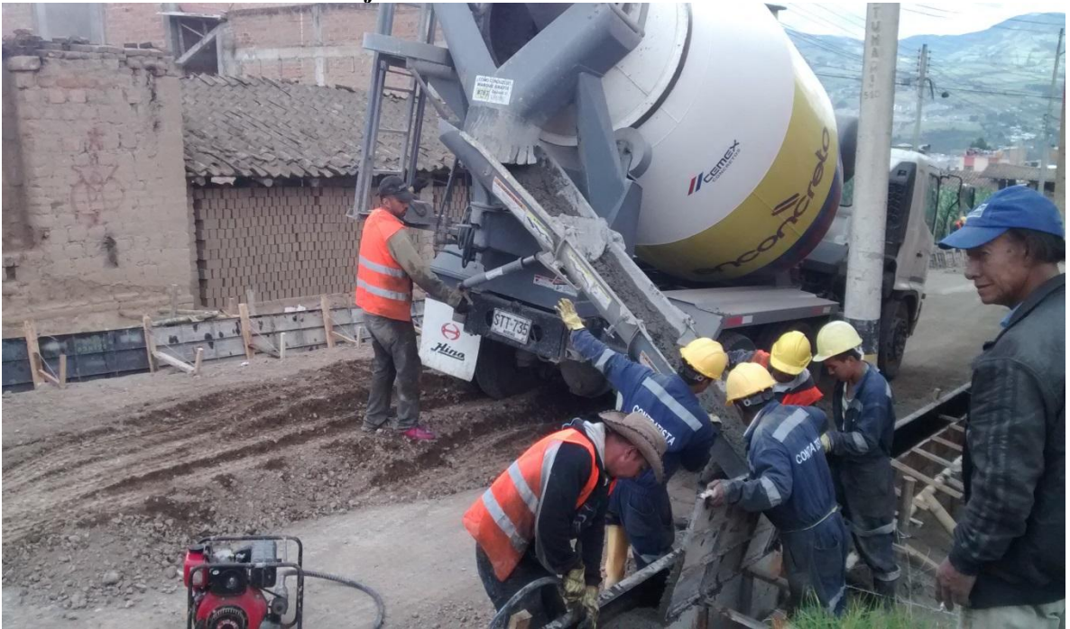
Trabajo de fundición de bordillos con mixers.
