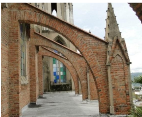
Figura 17. Arbotantes del Templo San Francisco de Asís. Fuente: el autor del proyecto
