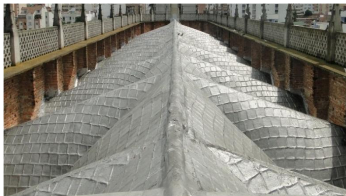
Figura 16. Bóvedas de la nave central impermeabilizadas. Fuente: el autor del proyecto
