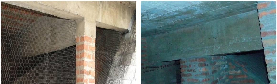
Figura 10. Vigas del templo en concreto reforzado. Fuente: el autor del proyecto.
