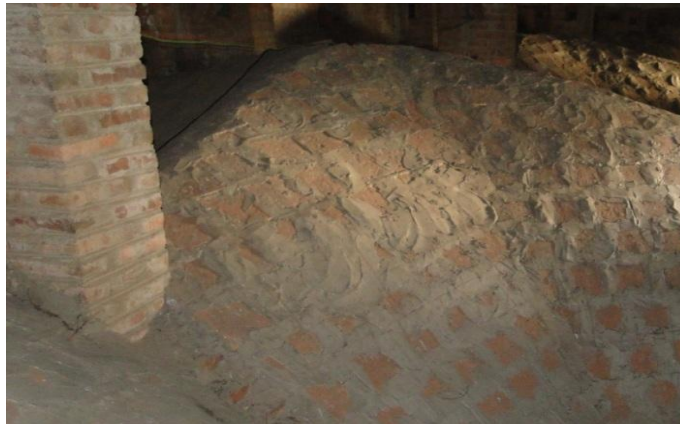
Figura 12. Bóvedas de las naves laterales. Fuente: el autor del proyecto.
