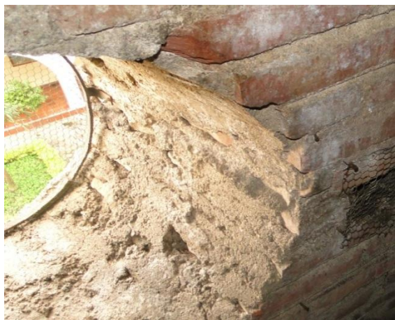
Figura 11. Muro de la fachada lateral. Vista del espesor. Fuente: el autor del proyecto.
