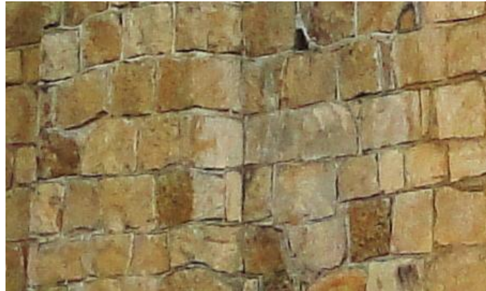
Figura 18. Sillares de piedra arenisca en las fachadas del templo. Fuente: el autor del proyecto.
