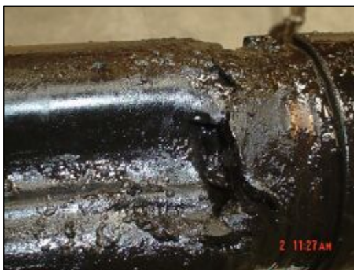
Figura 46. Daño mecánico en el protector tipo BPBSBPB
