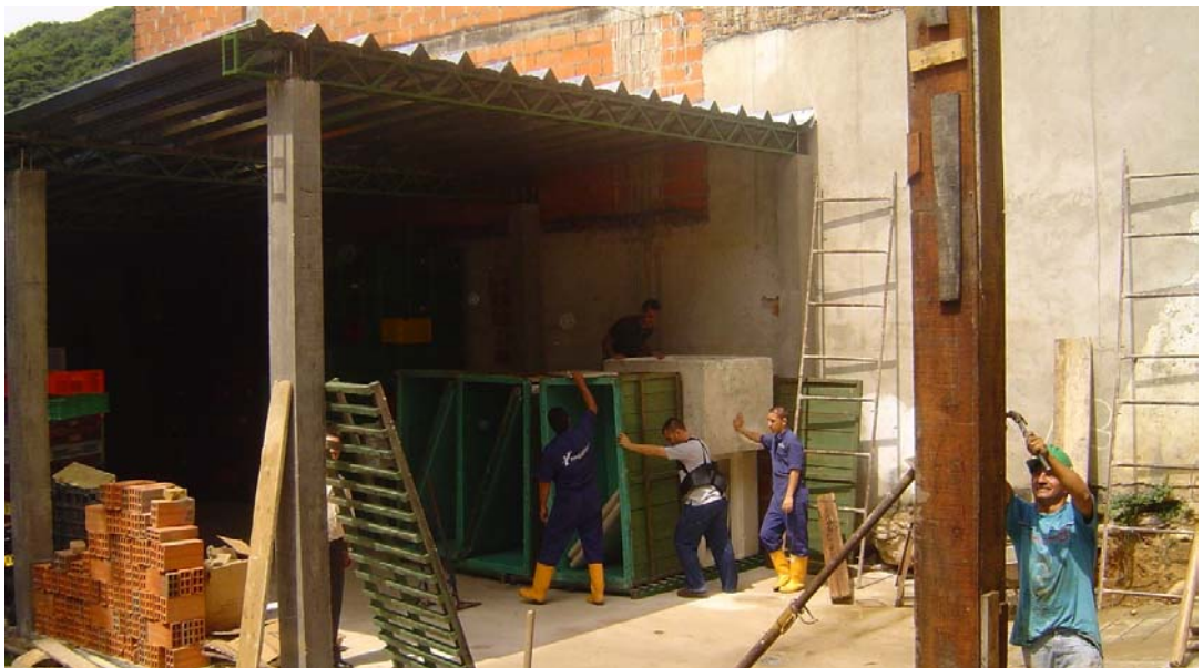
Adecuación espacio sub- utilizado
