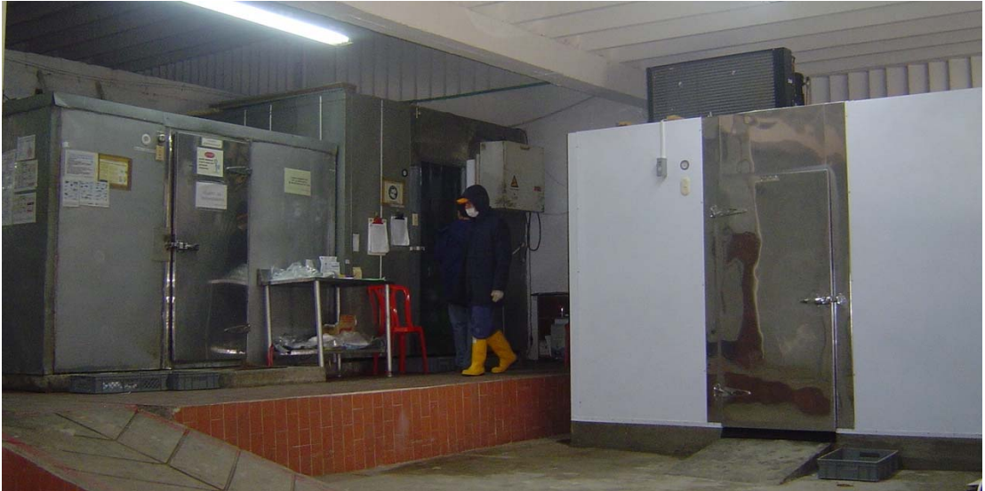
Nuevo cuarto frío
